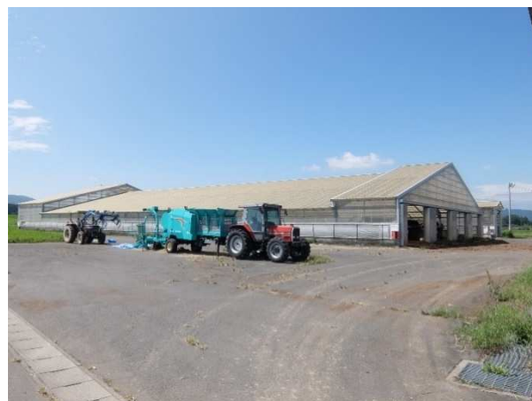
館矢間第一堆肥センター
