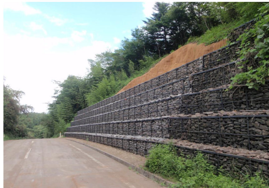
農道 (下梅ヶ作地区) 復旧後
