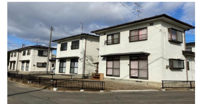
復旧後の町営金山住宅
