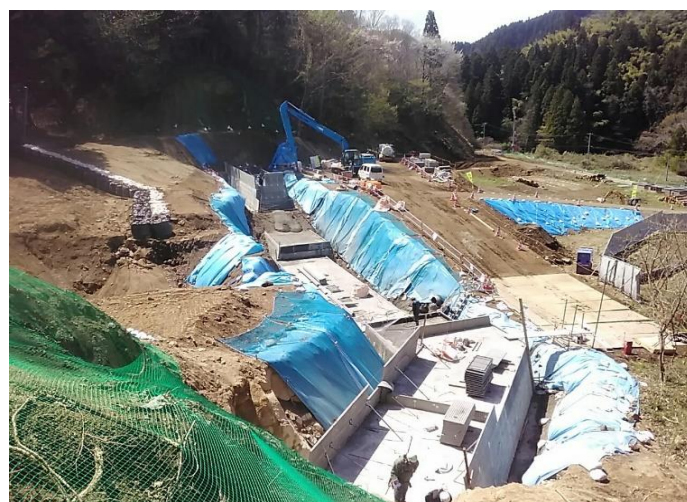
牛小沢砂防堰堤設置工事の様子
