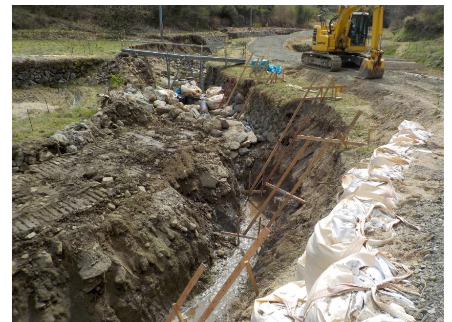
大和沢川(耕野大釜西)復旧工事の様子
