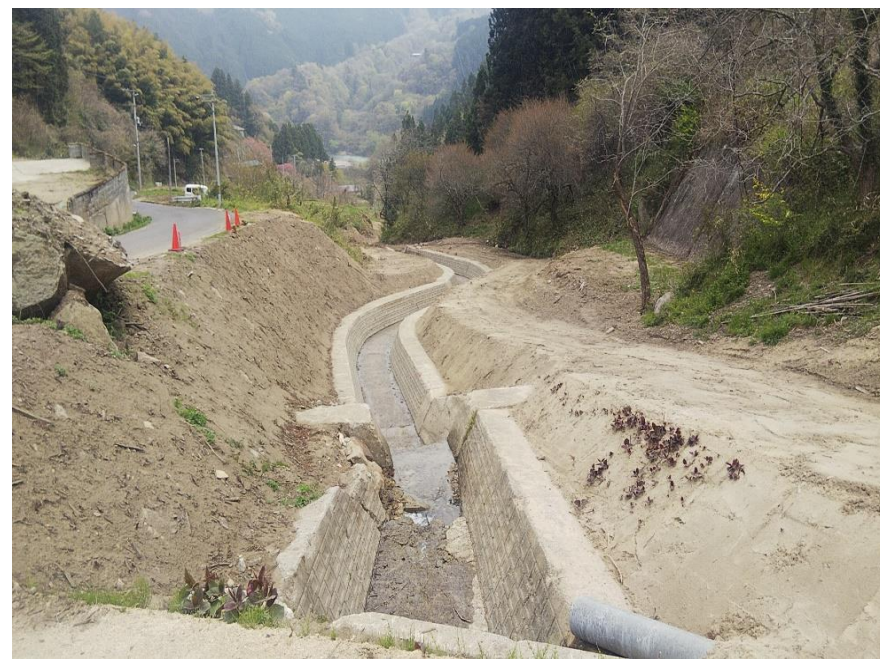
沢尻1号川 (大張川張字沢尻) 復旧後の様子
