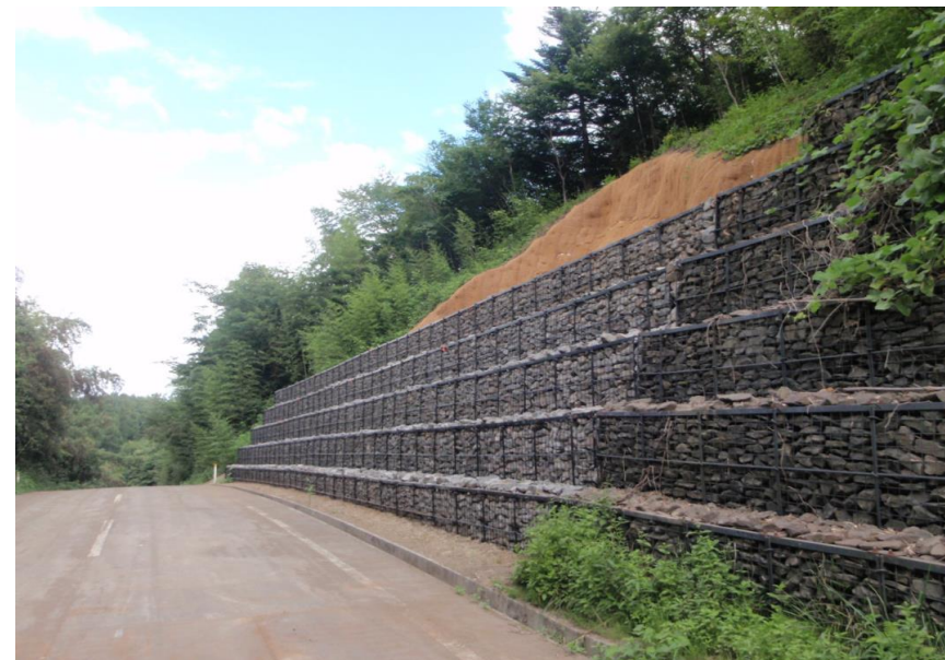
農道 (下梅ヶ作地区) 復旧後
