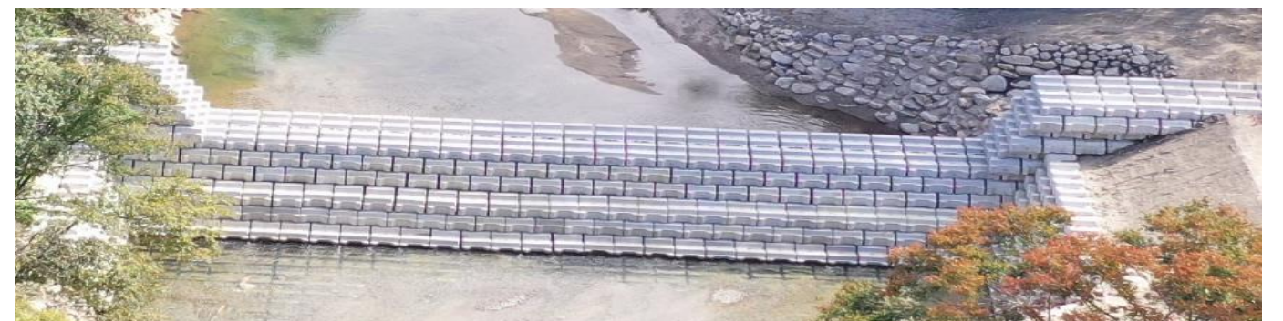
内川 (滝原地区) の床固工の様子
