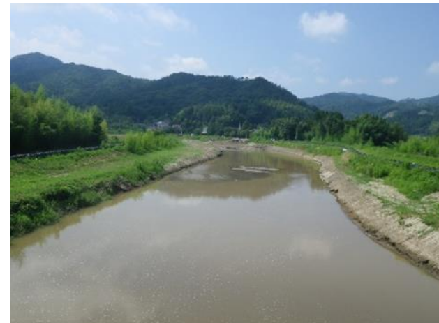
内川 (赤堀橋上流) 河道掘削後の様子
