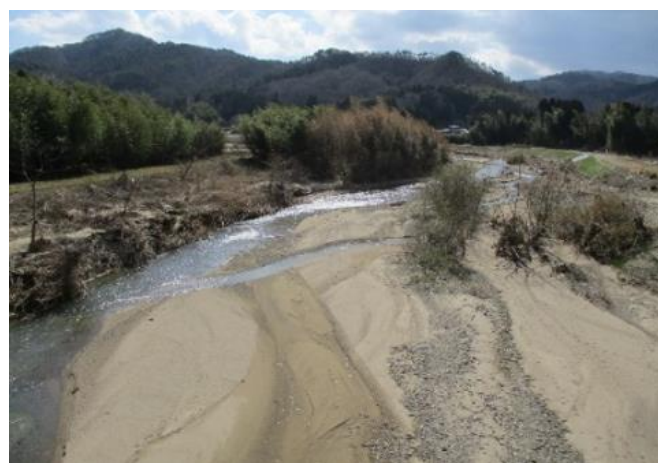
内川 (赤堀橋上流) 河道掘削前の様子
