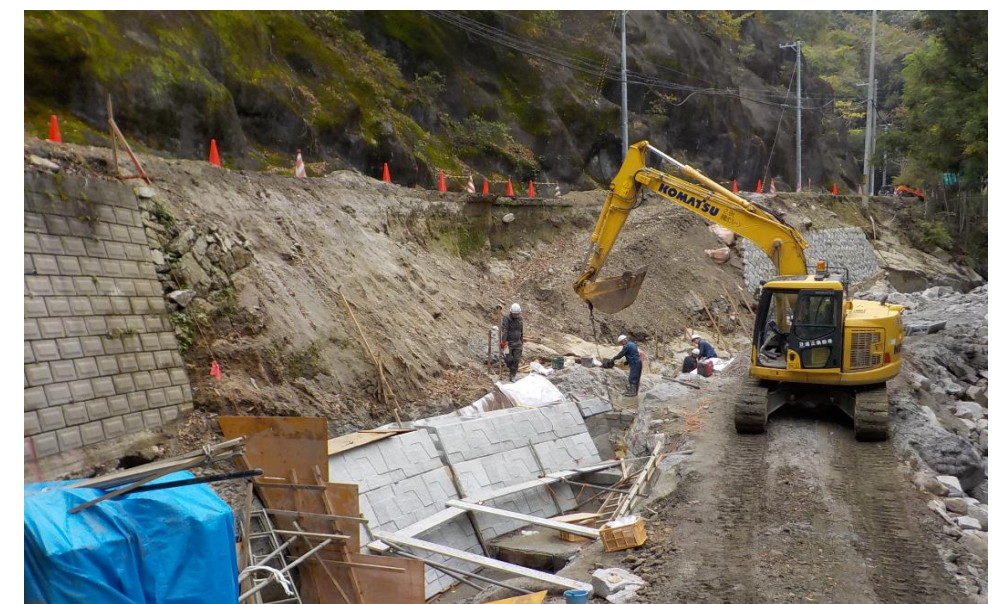
羽出庭線 (早坂) 道路復旧工事の様子
