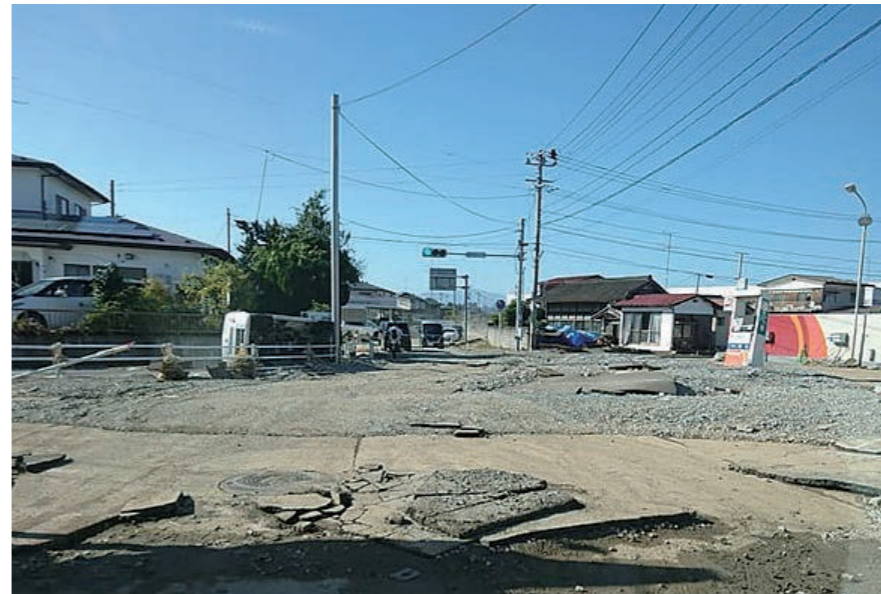
令和元年東日本台風による金山中心部の被害
