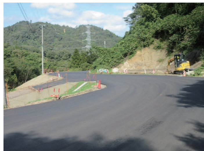
復旧工事が進む羽出庭砂ノ入線
