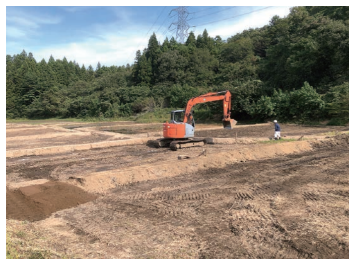
中山間地でも始まった農地復旧（大内地区）
