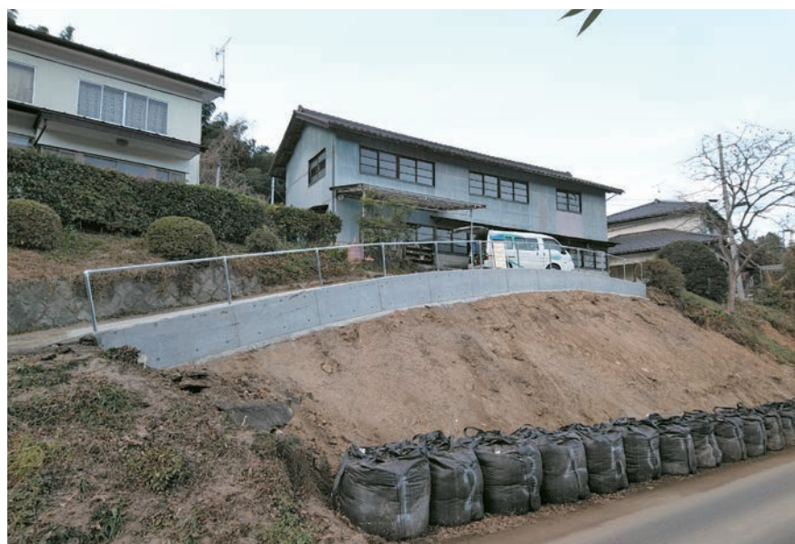
自力で行った宅地の災害復旧工事（耕野川向地区）
