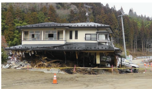
全壊した家屋（五福谷地区）
