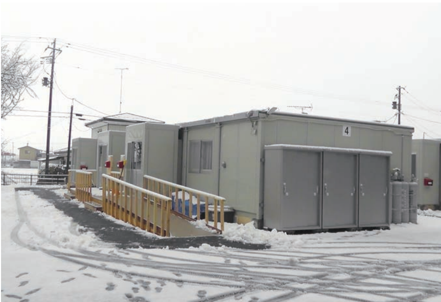
車椅子でも生活できるように設置されたスロープ（大館仮設住宅）
