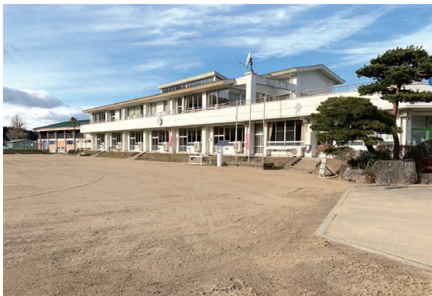
災害ごみが撤去された金山小学校
