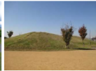
広場兼用資材備蓄 (備蓄土砂と水防用竹木)
