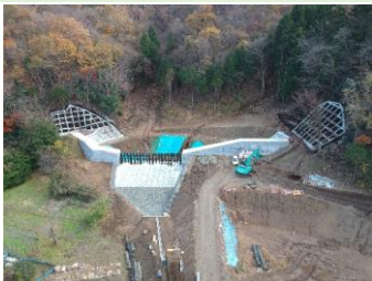
五福谷川(牛子沢堰堤工事)の様子
