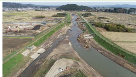
内川・五福谷川合流箇所河道掘削の様子
