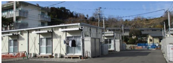
町西仮設団地
