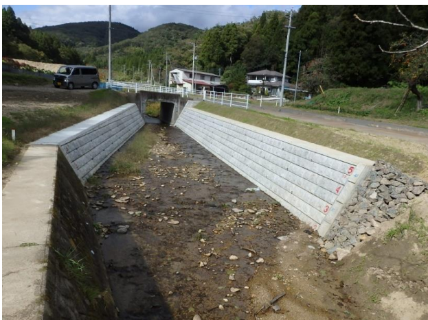
小坂川(館矢間山田字永作)復旧後の様子
