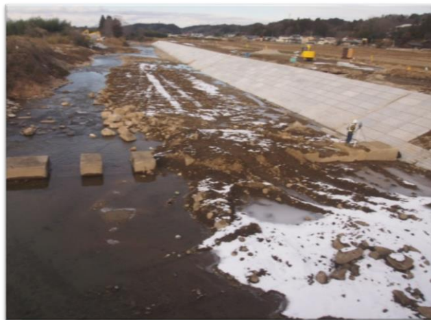
雉子尾川(大内字清水地先)復旧工事の様子
