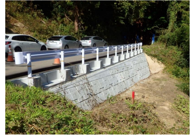
町道槌屋線(大張川張字槌屋)復旧後の様子
