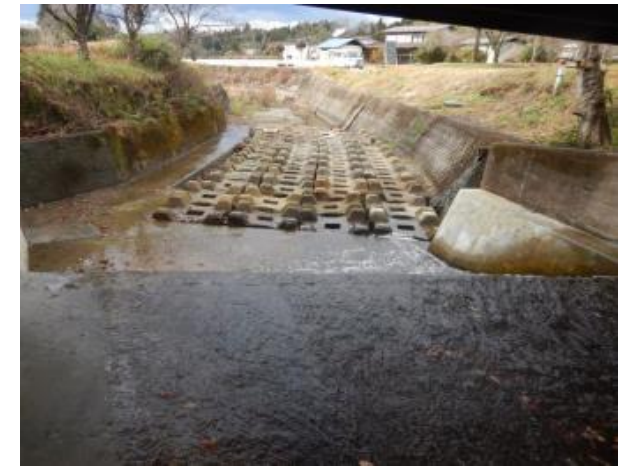
大内字桜町頭首工完成後の様子
