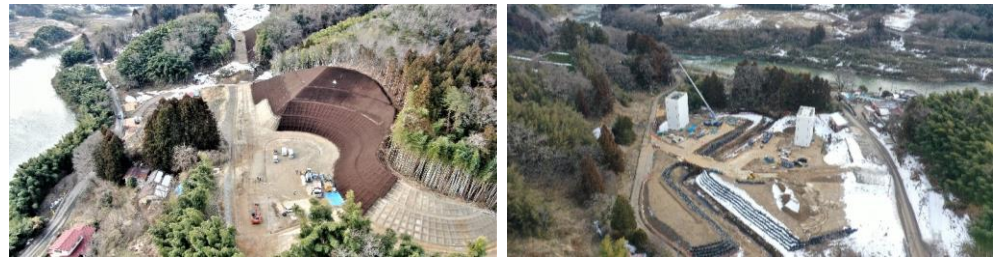
国道349号の別線(山側ルート)整備の様子
