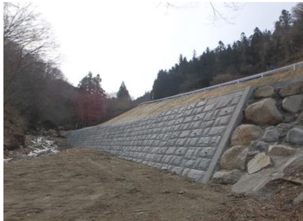
羽出庭川、羽出庭砂ノ入線(丸森町滝の上)復旧後の様子
