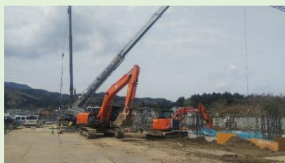
神明住宅(RC造)躯体工事の様子
