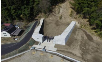
五福谷川(薄平沢堰堤工事)の様子
