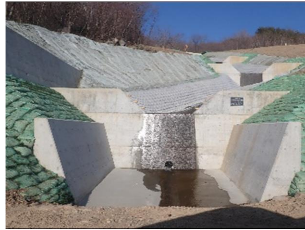
治山ダム(丸森町松)完成後の様子
