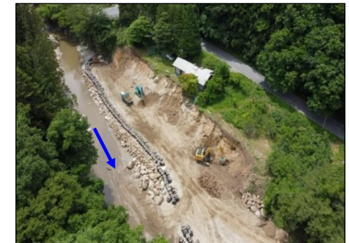
内川不動尊地区(護岸工事)の様子
