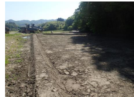
農地復旧後の様子(丸森町字五福谷)
