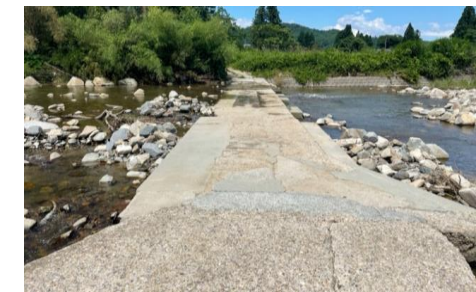
頭首工復旧後の様子(大内字石宇)
