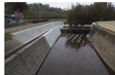
頭首工復旧後の様子(丸森町字天王)
