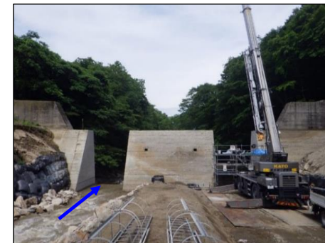
内川(東山砂防堰堤工事)の様子
