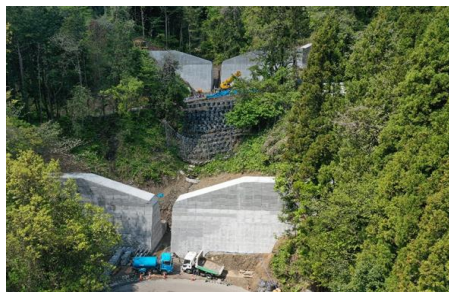
流路工事の様子(大張川張字槌屋)
