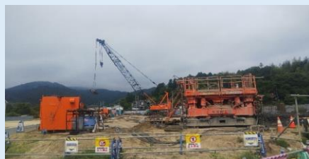
神明北住宅(RC造)基礎工事の様子
