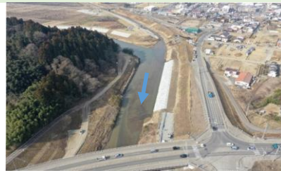
内川・五福谷川合流箇所河道掘削の様子
