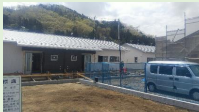
竹谷住宅建築工事の様子
