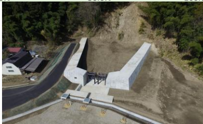
五福谷川(薄平沢堰堤工事)の様子
