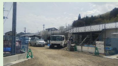
竹谷住宅建築工事の様子
