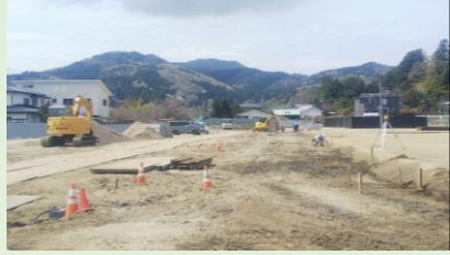
神明北住宅(木造)造成工事の様子
