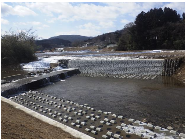
雫子尾川(大内宇中山地先)復旧後の様子
