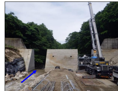
内川(東山砂防堰堤工事)の様子
