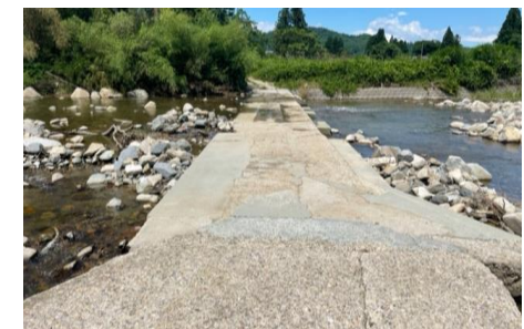
頭首工復旧後の様子(大内字石宇)
