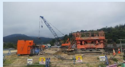
神明北住宅(RC造)基礎工事の様子
