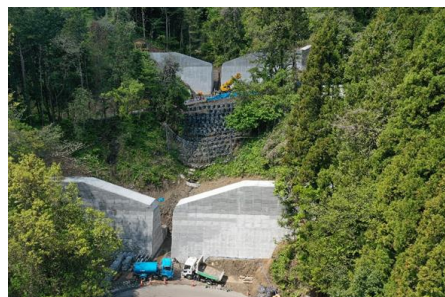
流路工事の様子(大張川張字槌屋)
