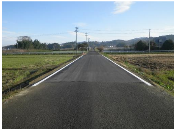
七ヶ新桜町線(大内字松沢)復旧後の様子
