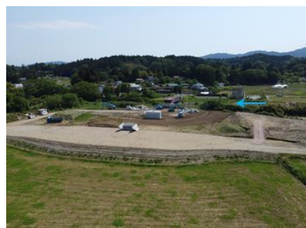
中平橋上部工工事・中平橋取付道路工事の様子(大内字中平)
