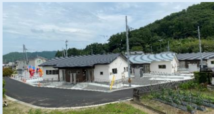
竹谷住宅(木造)完成後の様子
