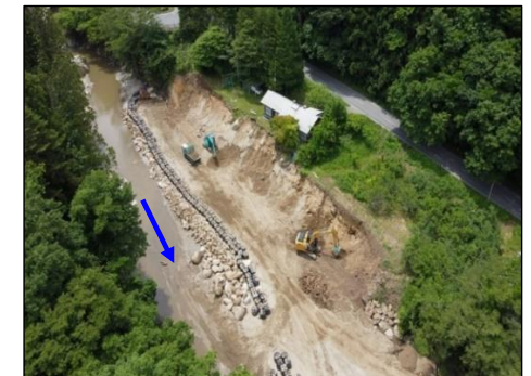
内川不動尊地区（護岸工事）の様子
