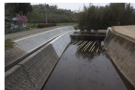
頭首工復旧後の様子(丸森町字天王)
