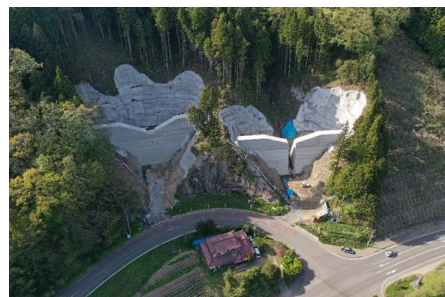
堰堤背面人工地山工事の様子(大張川張字片倉)
