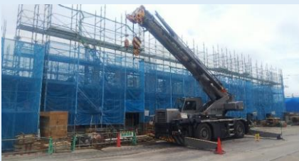
神明住宅(RC造)躯体工事の様子
