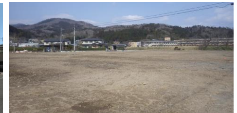
解体・撤去後の町営竹谷住宅
