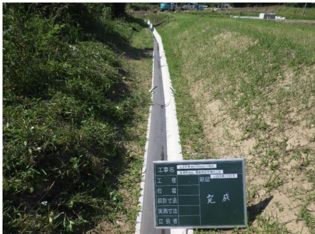
農業用水路(大内字東福田)復旧後の様子
