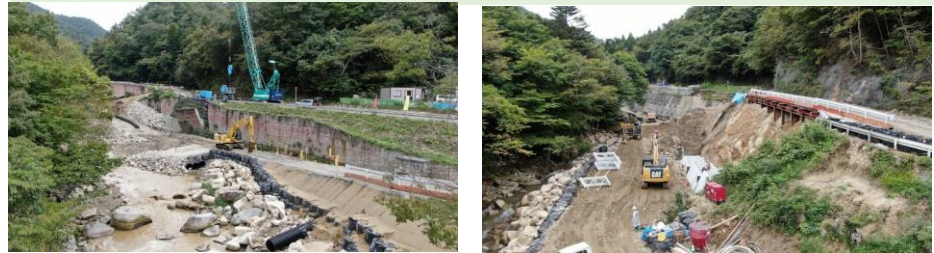
県道丸森霊山線復旧工事の様子
