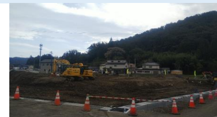
町営竹谷住宅建設中の様子
