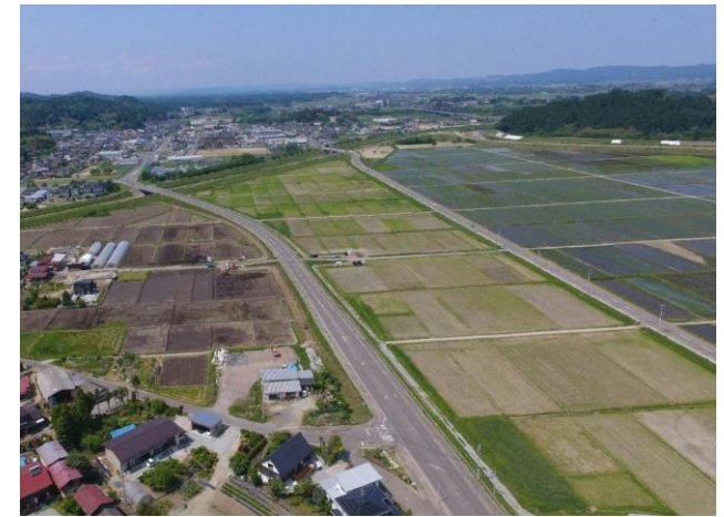
丸森字竹谷地区農地復旧後の様子
