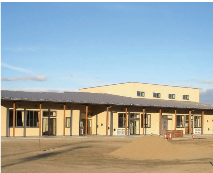
完成間近の「ひまわりこども園」(館矢間地区)
