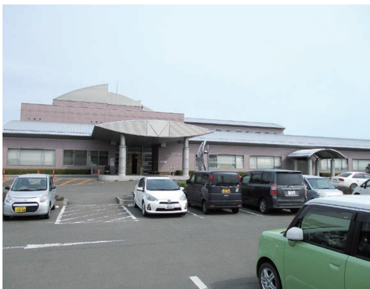
空調設備が全面改修される丸森病院
