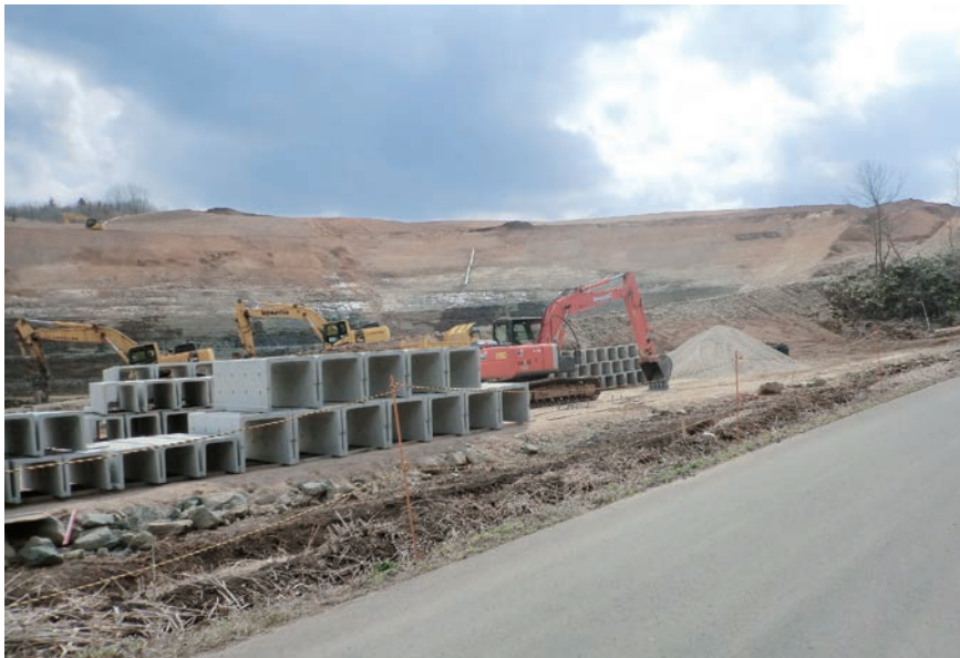
用地造成中のメガソーラー
