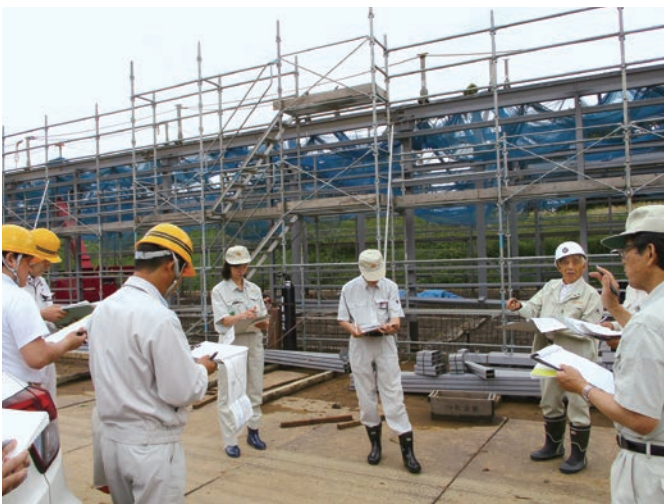
建設中の子牛育成センター（町放牧場内）
