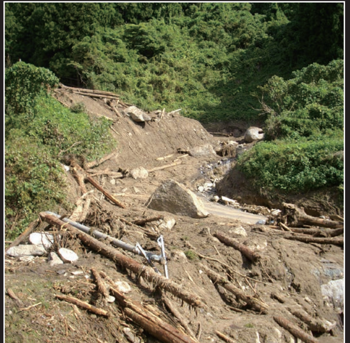
沢尻棚田に通じる町道（大張地区）
