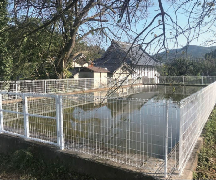
初期消火のための防火水槽（筆甫地区）
