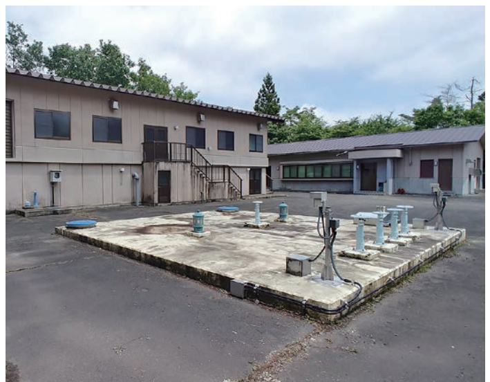
大内地区他に給水する黒佐野浄水場
