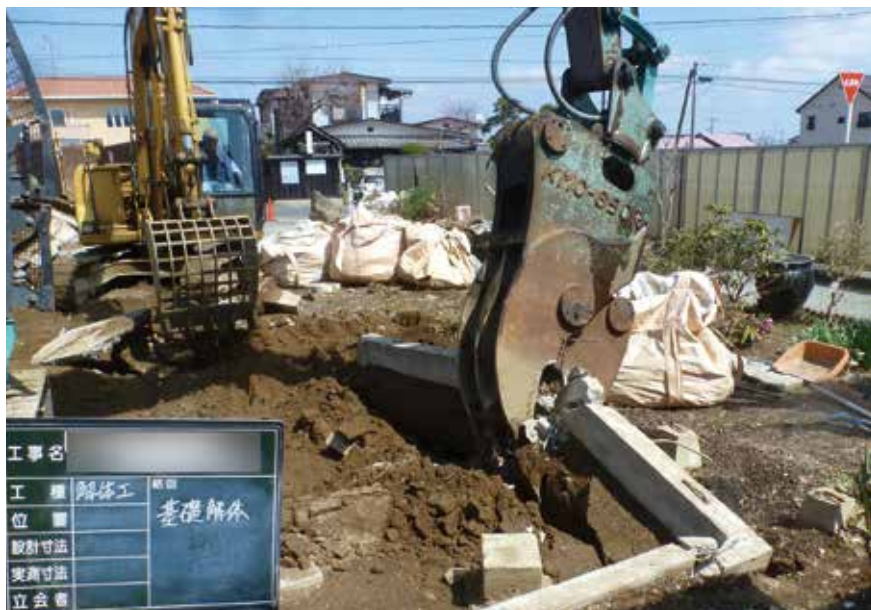
公費解体が始まった被災家屋
