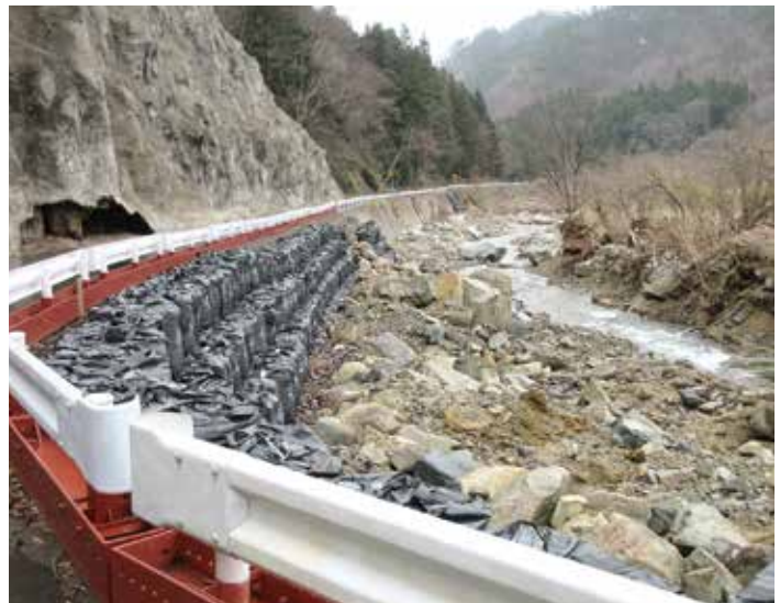
仮復旧が終了した丸森霊山線
