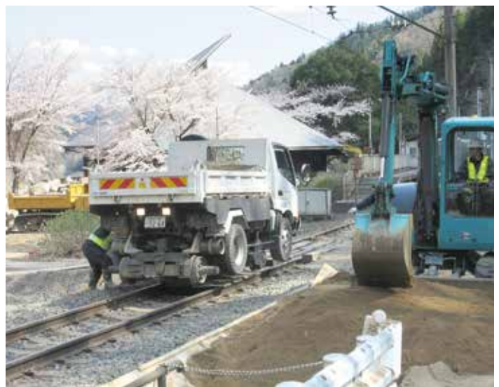
復旧工事が進む、あぶくま駅周辺
