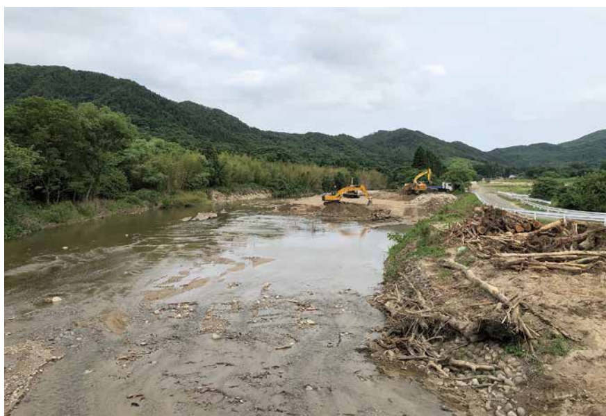
早くも着工：国の内川土砂撤去工事（丸森地区）
