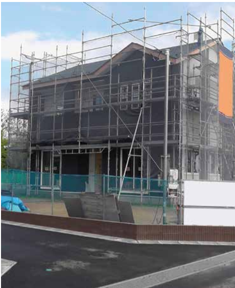
町内での生活再建を決意した被災者新居（館矢間地区）
