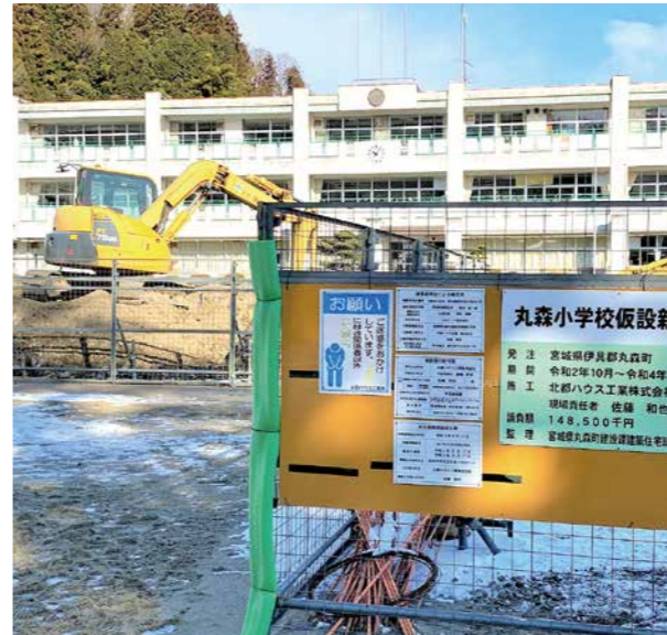
建設中の丸森小学校仮設校舎
