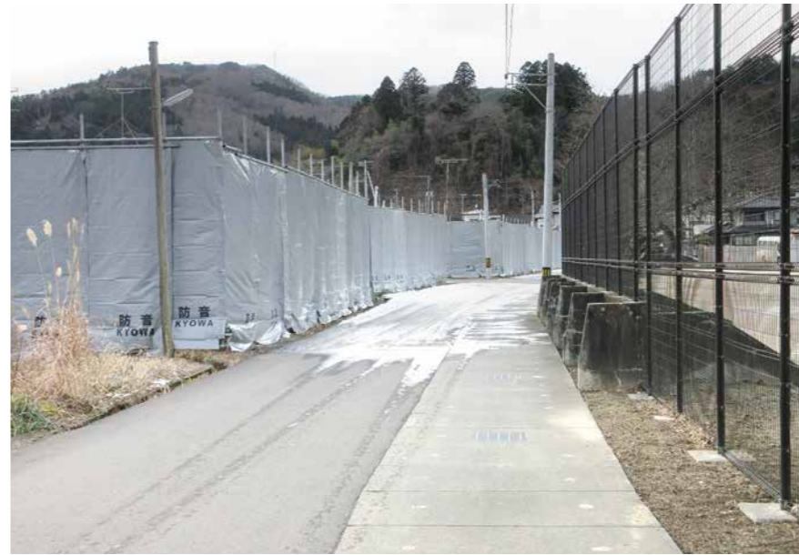
解体工事が進む鳥屋町宮住宅
