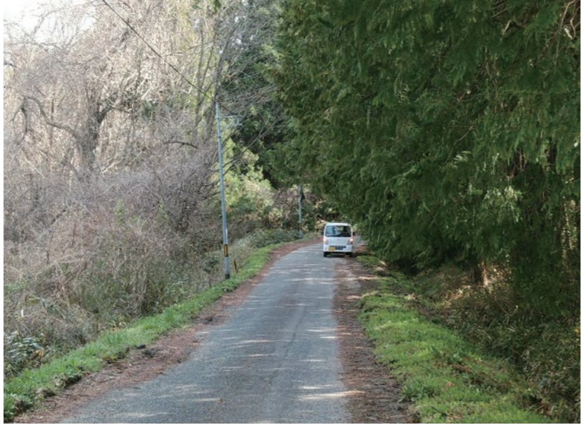
見通し日当たり悪化、車両接触、障害となっている道路脇の立木
