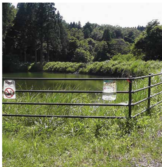
すでに安全対策がされているため池 (大内地区)
