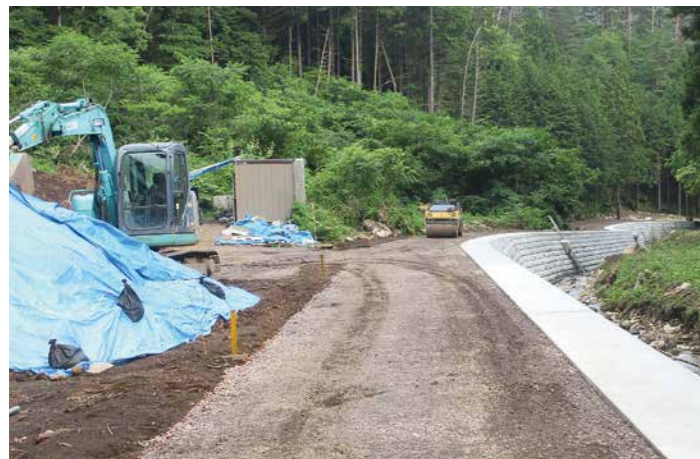
復旧工事が進む郡見古田線（筆甫地区）
