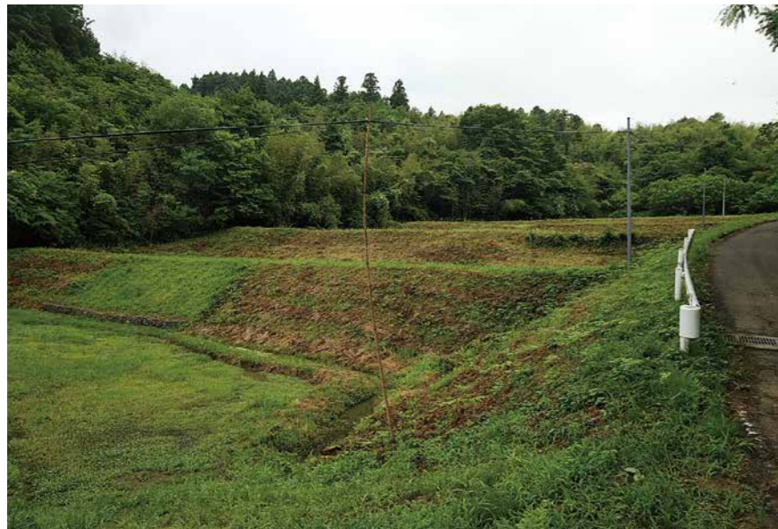
災害復旧工事が完了した水田 来春の作付は未定（耕野地区）
