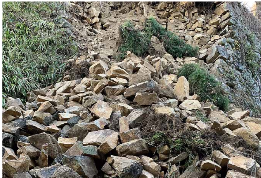
大きく崩落した石垣（金山城址）
