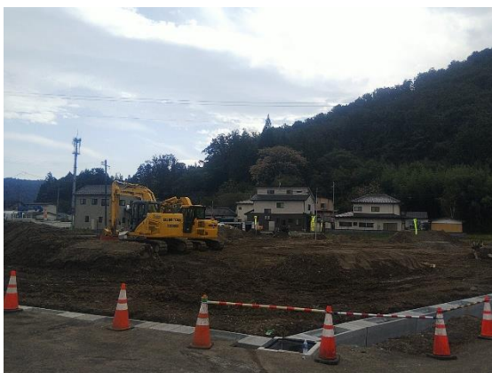
竹谷住宅建設中の様子
