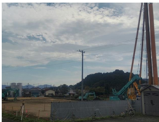
災害公営住宅建設中の様子
