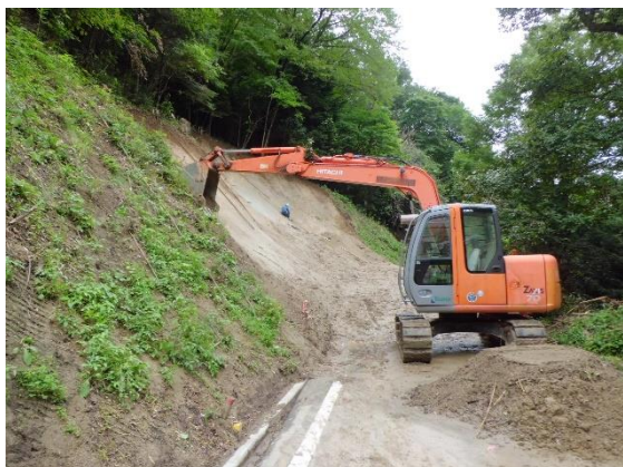
西畑線(館矢間山田)復旧工事の様子
