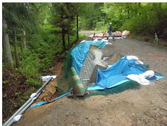
市子沢線(館矢間松掛)復旧工事の様子
