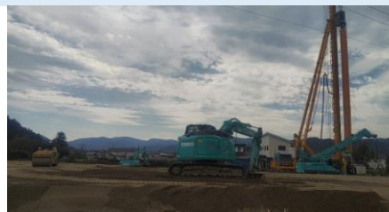
災害公営住宅(神明北)建設中の様子
