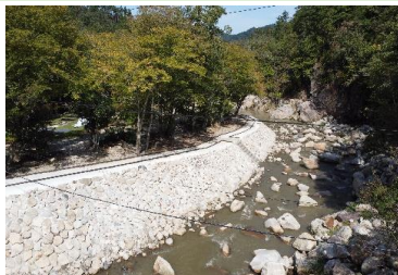
内川(丸森字不動地先)護岸復旧の様子
