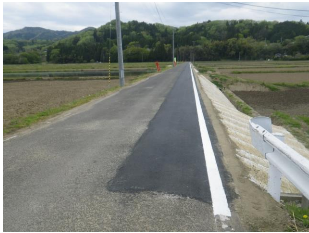
町道竹ノ内線(大内字西向中)復旧後の様子
