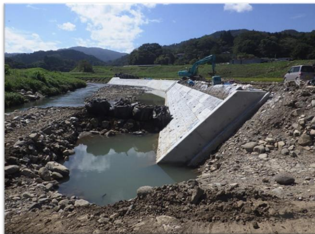
雉子尾川(大内字佐野西下地先)復旧工事の様子
