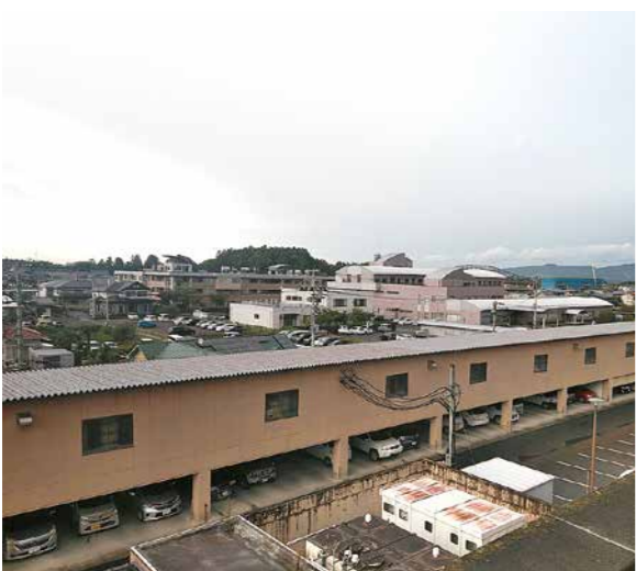
50kw太陽光発電も設置します(役場北側車庫)
