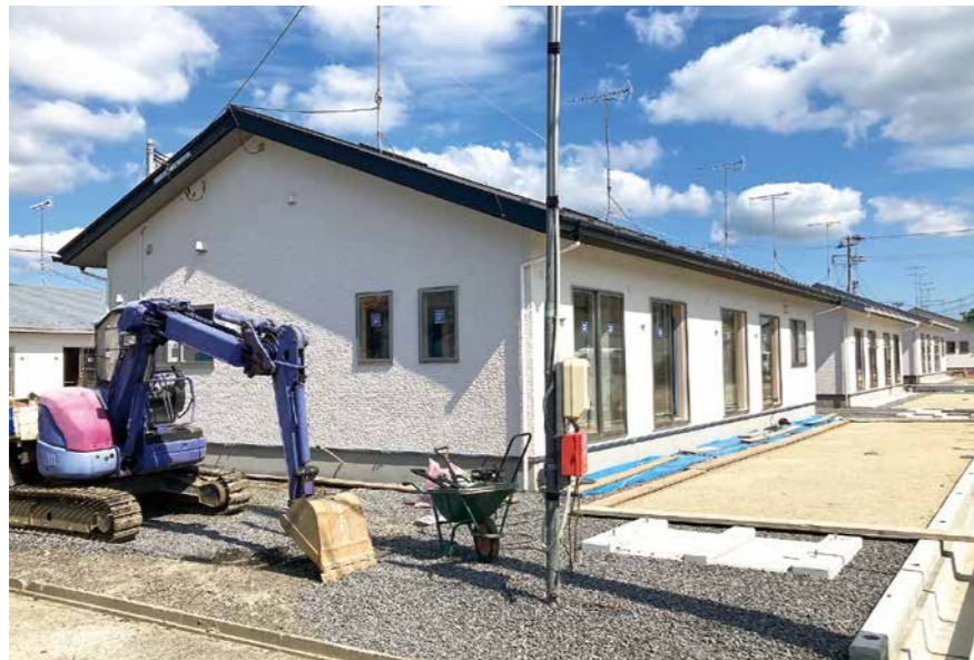
完成が待たれる町営住宅（丸森神明地区）
