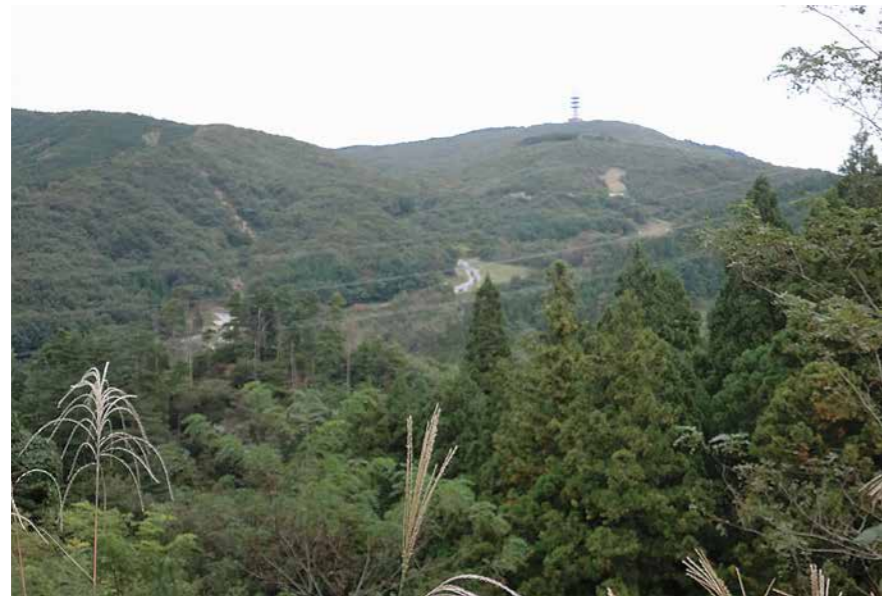
なぜ崩れた山の近くに風力発電を（丸森羽出庭地区）
