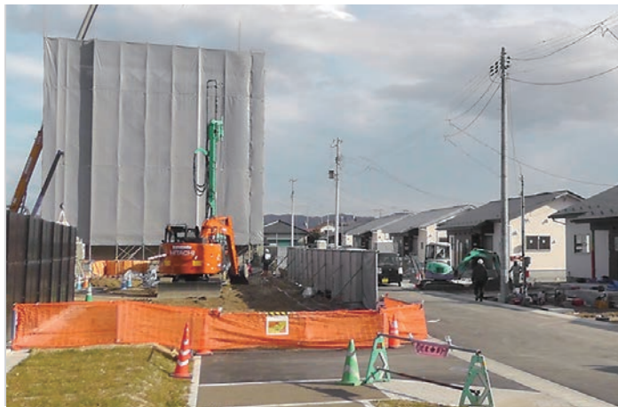
急ピッチに進む災害公営住宅工事（丸森町神明北地区）
