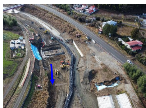
和田堰工事の様子（丸森町字上林南）
