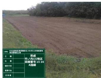
農地復旧後の様子(大内字竹ノ内)
