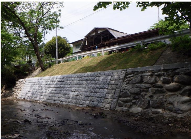
佐野青葉線復旧後の様子(大内字青葉西)
