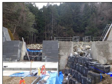
砂防堰堤工事（改築）の様子（丸森町字土ヶ森）
