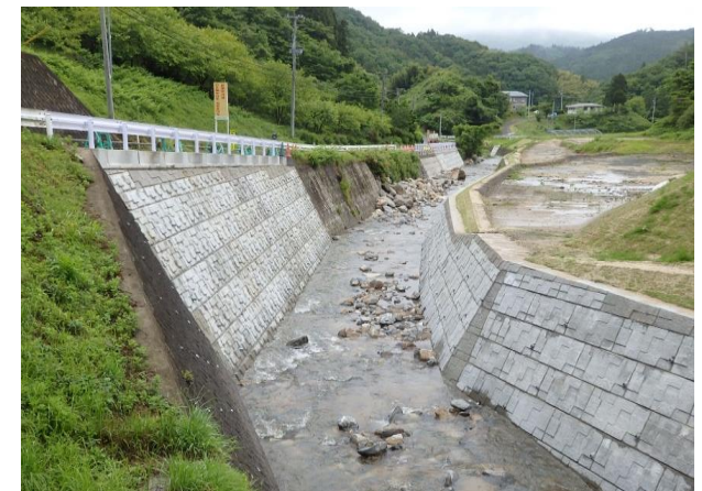
芦沢川復旧後の様子（耕野字火石坂）
