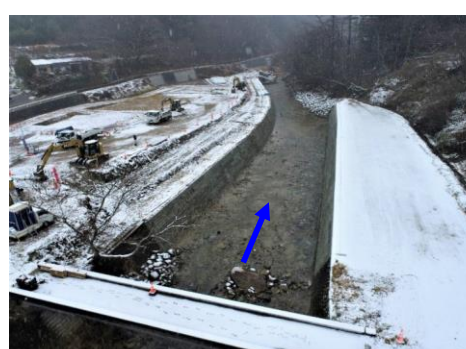
内川護岸工事完成後の様子〈筆甫字川下一〉
