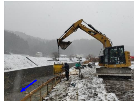
内川護岸工事の様子〈筆甫字平館〉
