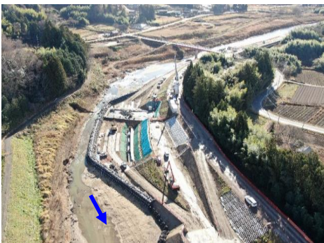
山下堰工事の様子（丸森町字上林東）
