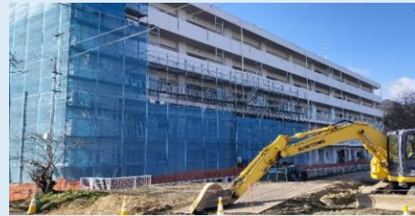
神明住宅(RC造)建設工事の様子
