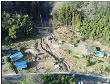
砂防堰堤工事（新築）の様子（丸森町字大畑）
