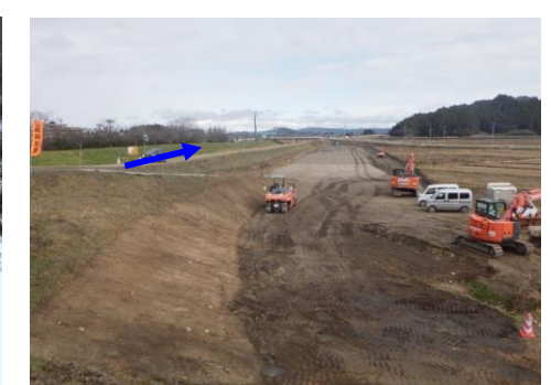
新川盛土工事の様子〈丸森町字土橋〉
