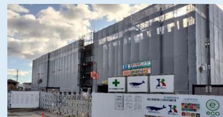
神明北住宅(RC造)躯体工事の様子
