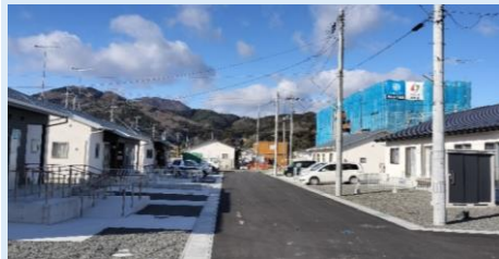
完成した神明住宅(木造)東側工区の様子
