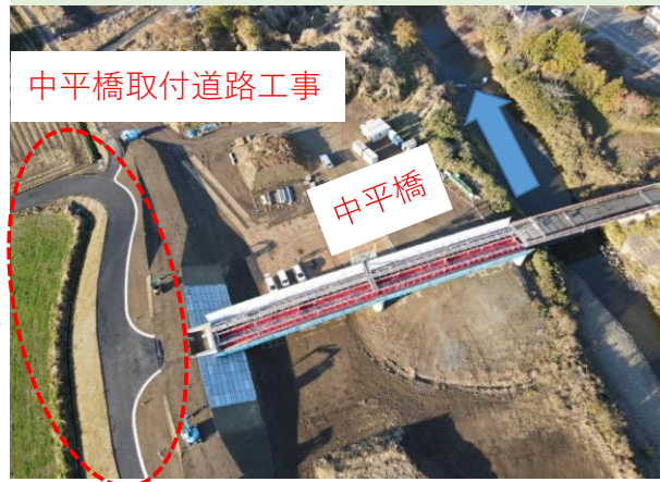
中平橋取付道路工事完成後の様子(大内字石神)
