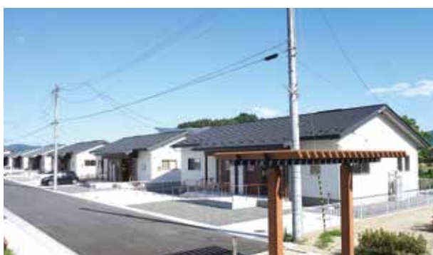
町産材を使用して整備した町営神明住宅
