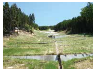
治山工事により復旧した廻倉地区
