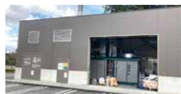
視察先：静岡県小山町 ジャストワン富士小山ホテルに併設された「木質バイオマス発電所」
