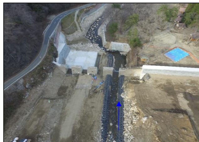
砂防堰堤工事（改築）の様子（宇都宮）
