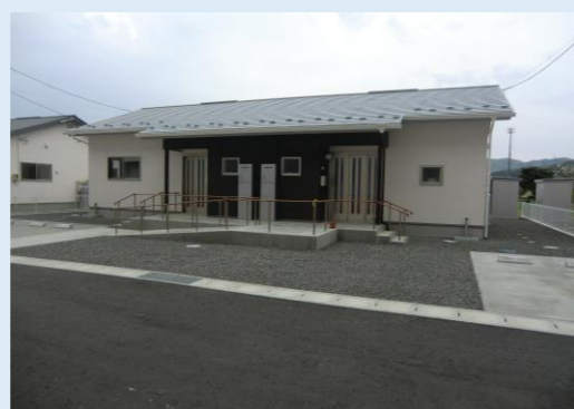
神明北住宅(木造)完成後の様子
