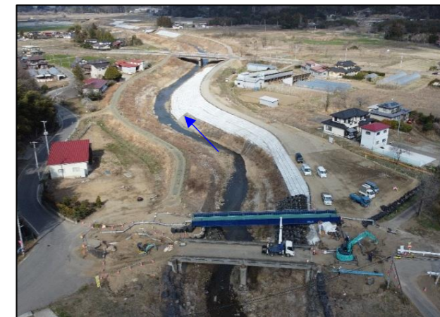
五福谷川水道仮橋工事の様子（字塚田）
