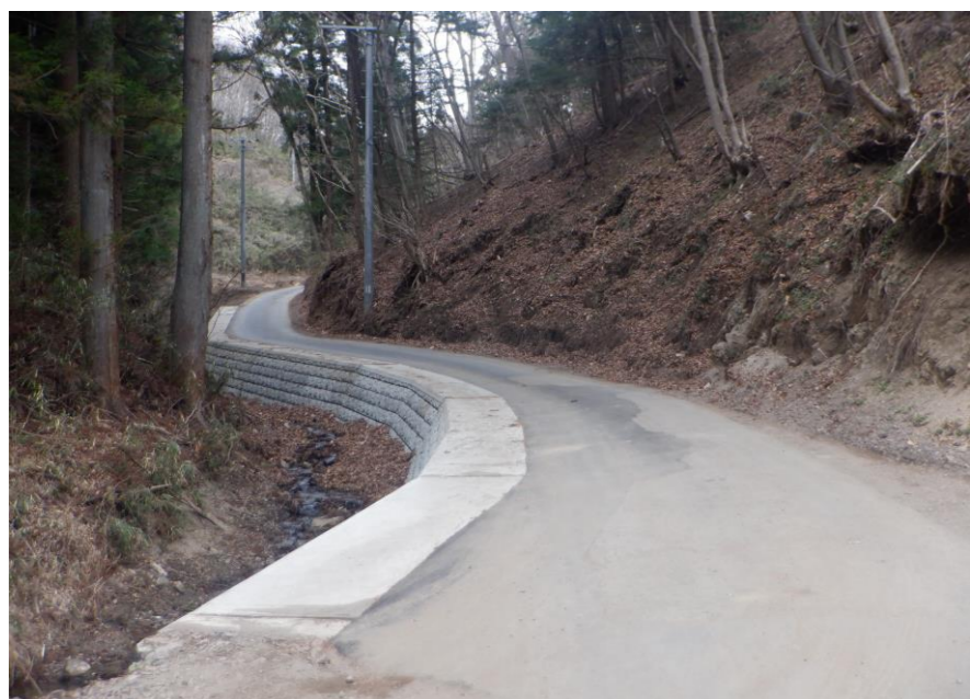
町道 井戸尻線 路肩復旧工事
