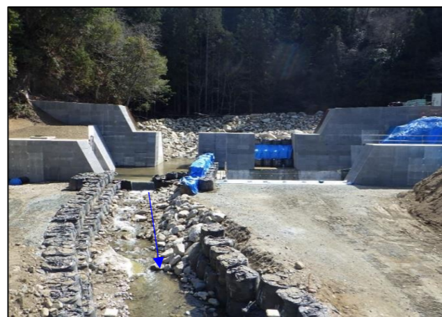
砂防堰堤工事（改築）の様子（宇都宮）
