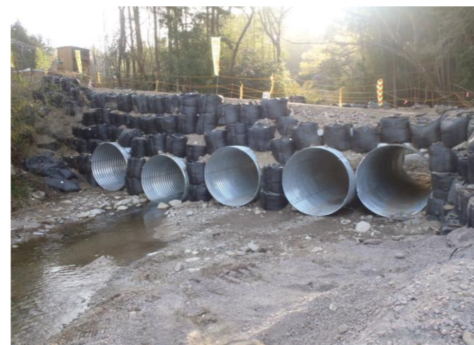
馬淵橋外災害復旧工事(仮設工事)
