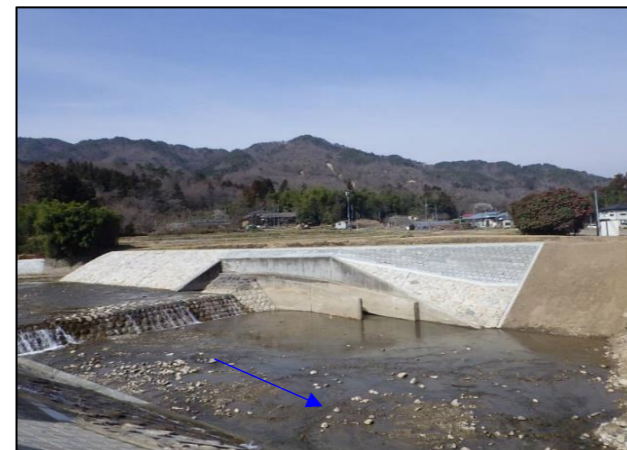
内川護岸工事完了後の様子（字滝原）
