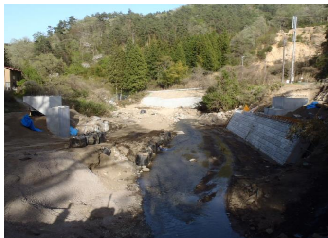
馬淵橋外災害復旧工事(全体写真) (R5年度未完了予定)
