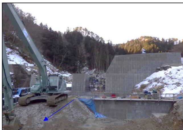
砂防堰堤工事（改築）の様子（宇都宮）
