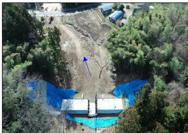
砂防堰堤工事（新築）の様子（宇都宮）
