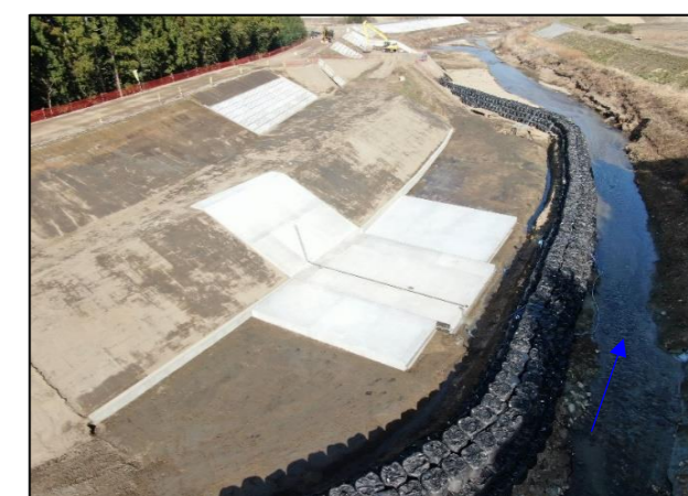
内川山下堰工事の様子（字上林東）
