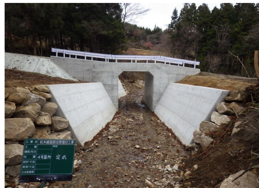
林道枯木線4号箇所 災害復旧工事
