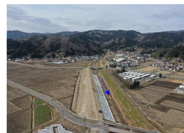
新川築堤工事の様子（字土橋）
