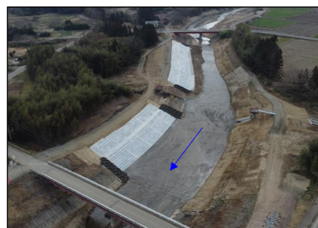
内川護岸工事の様子（字前河原）
