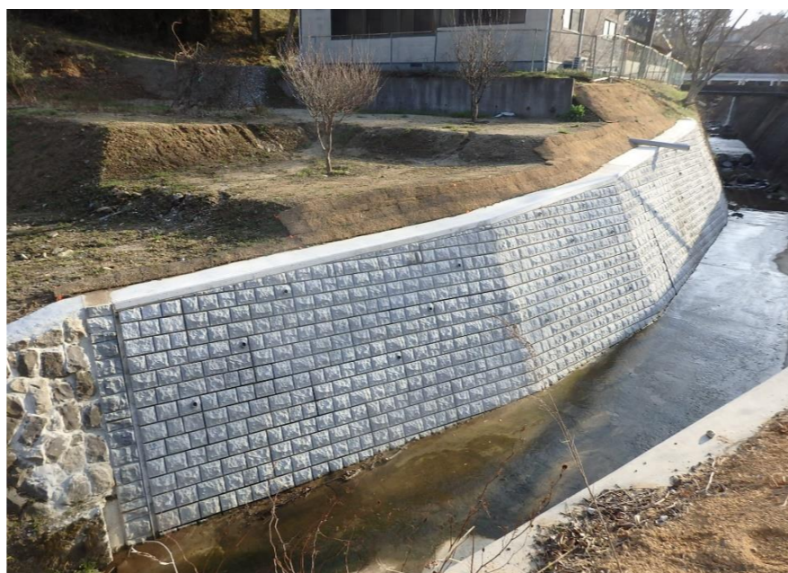
大蔵川(右岸) 護岸復旧工事
