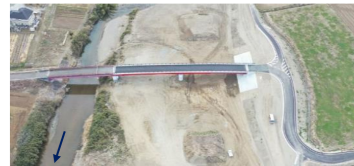
中平橋設置工事(完成：大内字石神)
