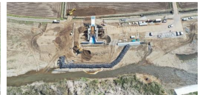
三代河原橋～中平橋間排水樋門工事(R5.6月完成予定)
