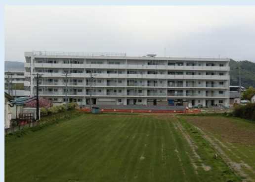
神明北住宅(RC造)建設工事の様子
