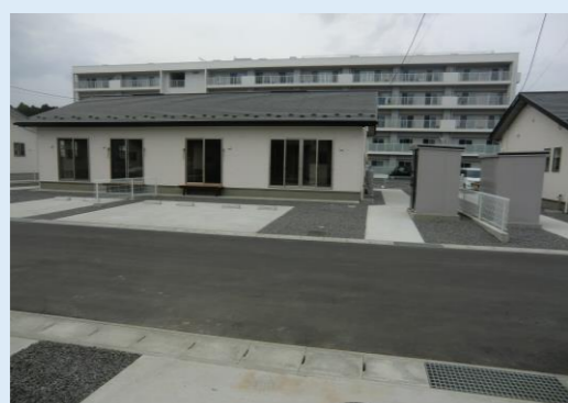
神明住宅(木造)建完成後の様子
