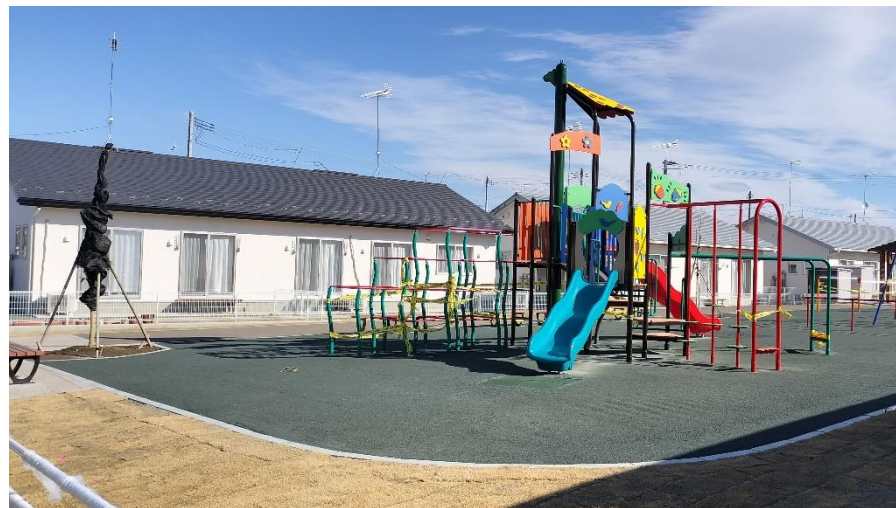
東側工区24戸完成後の様子（木造）
