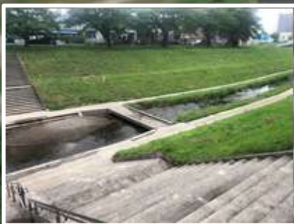
渡河橋の事例（仙台市荒川）
