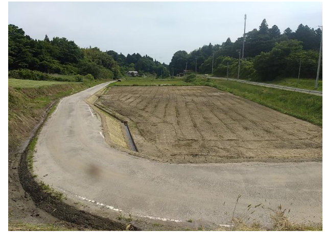
農地復旧後の様子（丸森町字羽出庭）
