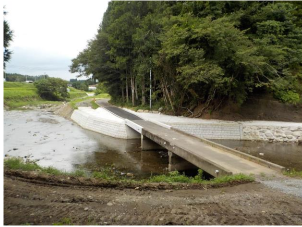
佐野西下橋復旧後の様子（大内字佐野西下）
