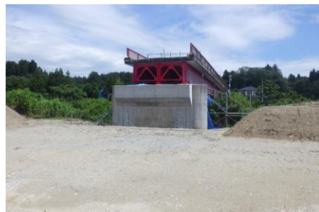
中平橋上部工工事の様子(大内字中平)
