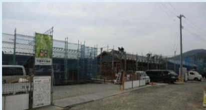
神明北住宅(木造)建設工事の様子
