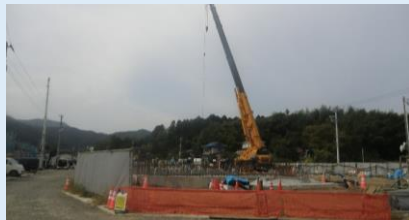
神明北住宅(RC造)躯体工事の様子
