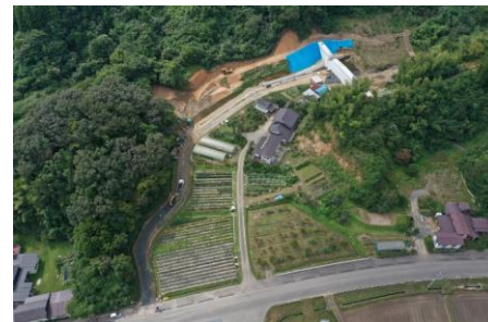
砂防堰堤流路工事の様子(館矢間山田字永作)
