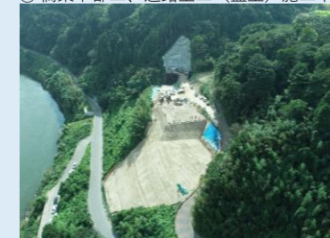
④ 橋梁下部工、道路土工(盛土)施工中
