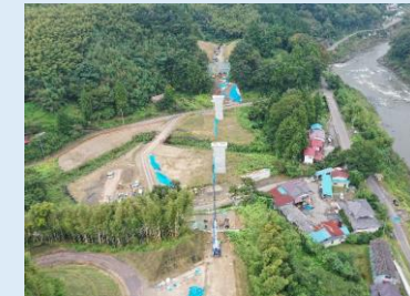
④ 橋梁下部工、道路土工(盛土)施工中
