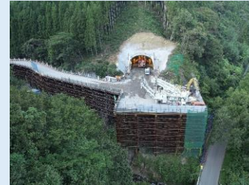
③ トンネル坑口部擁壁施工中
