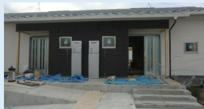
神明住宅(木造)建設工事の様子
