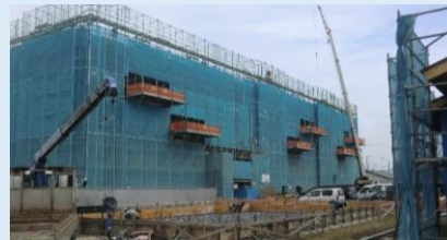
神明住宅(RC造)建設工事の様子
