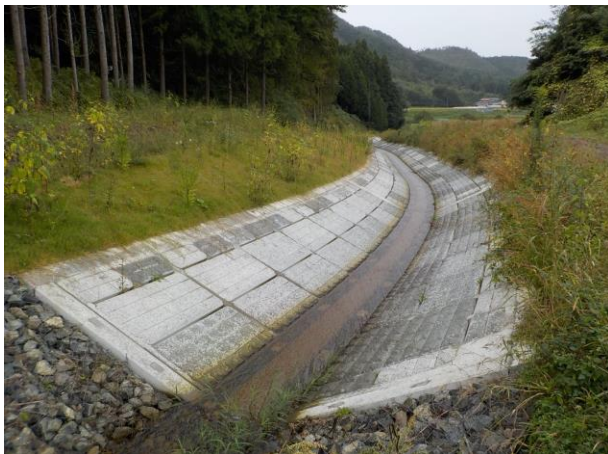
聖川復旧後の様子（大内字高田）
