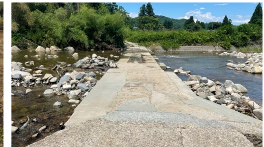
頭首工復旧後の様子(丸森町字石宇)
