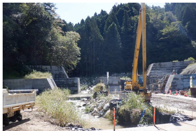
砂防堰堤工事（改築）の様子（字土ヶ森）
