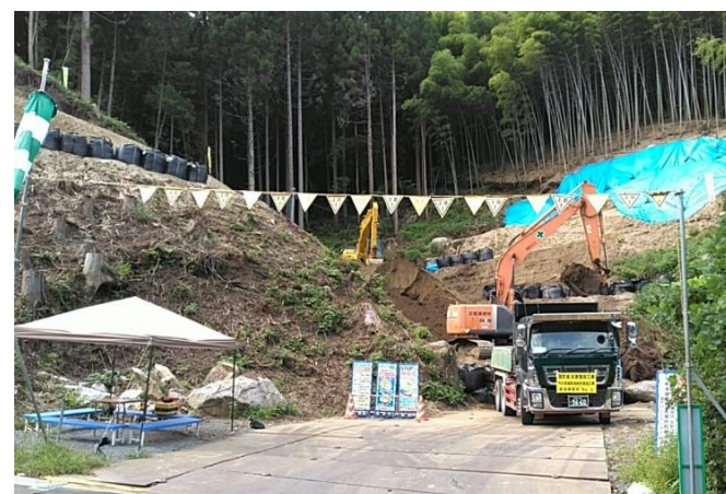
砂防堰堤工事（新築）の様子（字原場）
