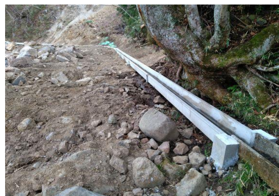
裏区下水路復旧工事の様子（筆甫地区）
