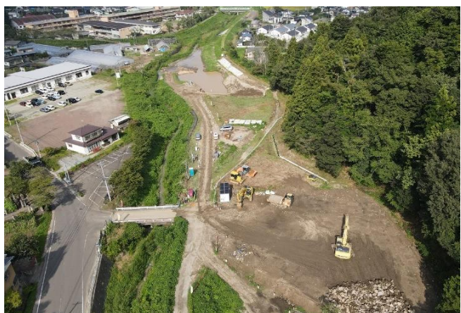
遊砂地工事の様子（字虚空蔵下）
