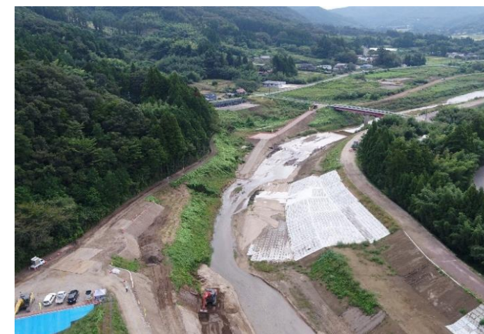
内川山下堰工事の様子（字上林東）
