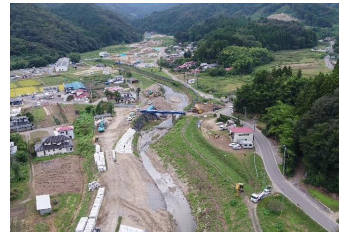
五福谷川水道仮橋工事の様子（字塚田）
