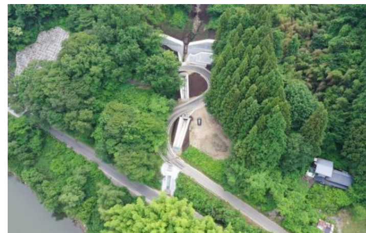
阿武隈川左岸砂防流路工事(左岸8)完了後の様子(槌屋沢1)
