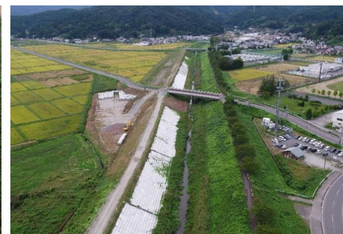
新川築堤工事の様子（字愛宕田）
