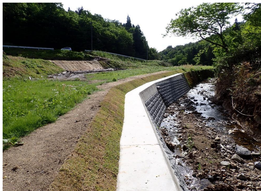
内川河川災害復旧工事完了後の様子（筆甫地区）
