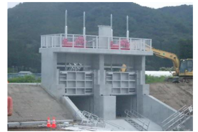
排水樋門ゲート工事の様子
