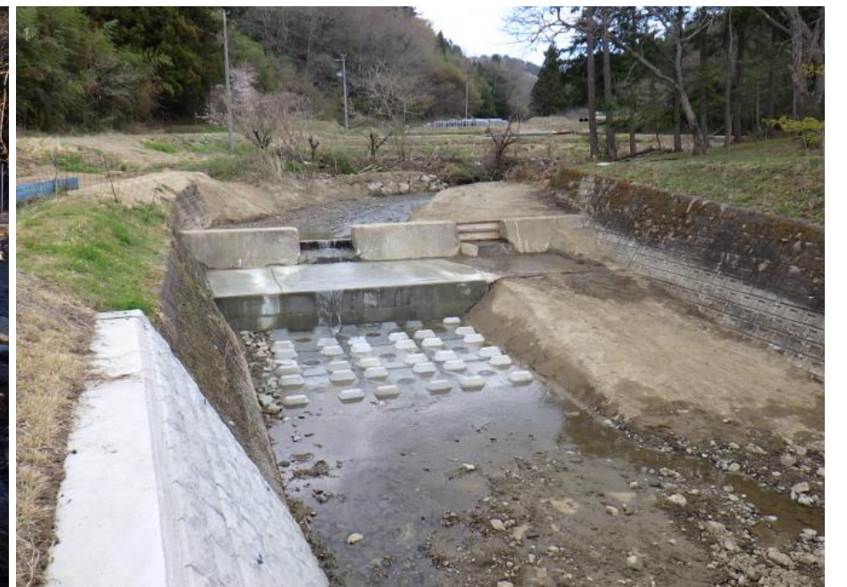
鬼ヶ柵地区頭首工工事完了後の様子（大内地区）
