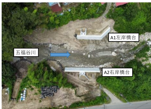
馬淵橋橋梁工事の様子
