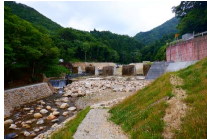
砂防堰堤工事（改築）の様子（字不動）
