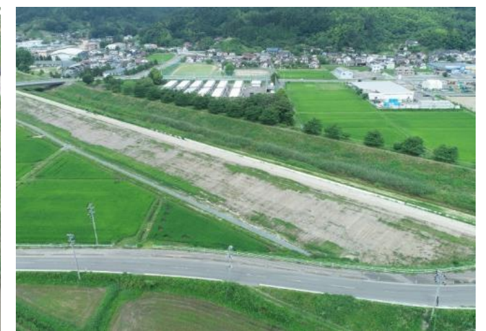
新川築堤工事の様子（字愛宕田）
