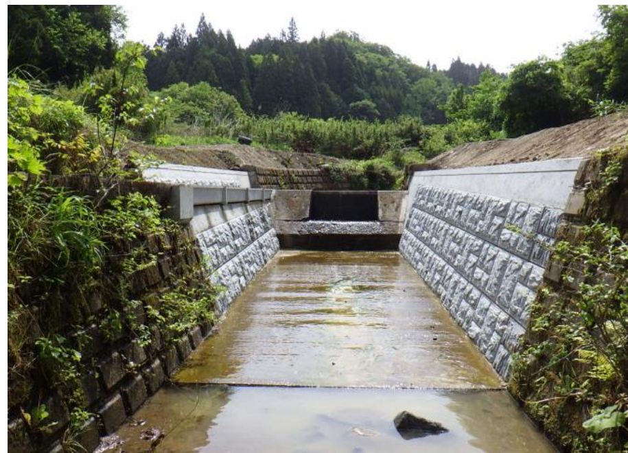
岩ノ入第1頭首工工事完了後の様子（大内地区）
