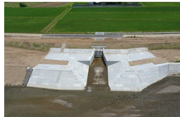
排水樋門工事完了後の様子
