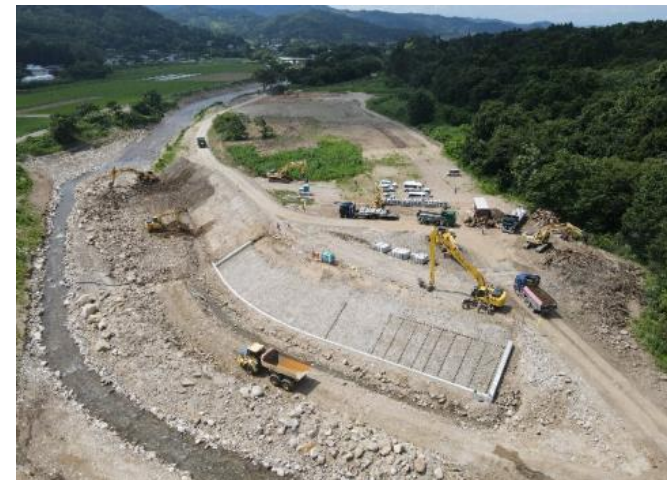
内川護岸工事の様子（字桜淵）
