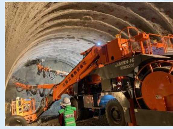
① 1号トンネル掘削工事の様子
