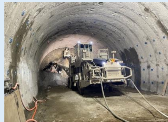
③ 3号トンネル掘削工事の様子
