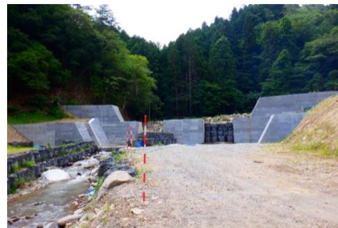
砂防堰堤工事（改築）の様子（字土ヶ森）
