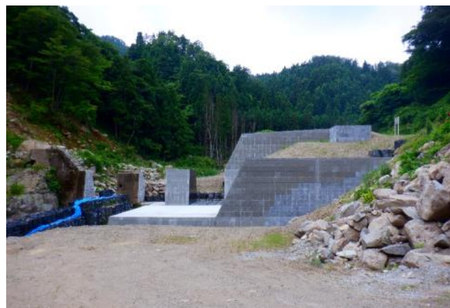
砂防堰堤工事（改築）の様子（字薄平）
