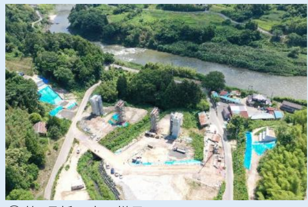
② 第1号橋工事の様子
