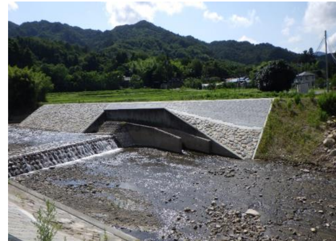
内川護岸工事完了後の様子（字滝原）
