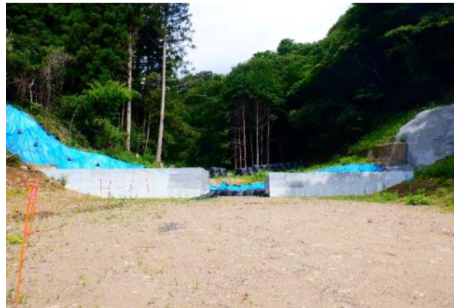
砂防堰堤工事（新築）の様子（字大畑）
