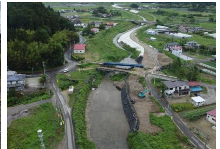
五福谷川河道掘削工事の様子（字塚田）
