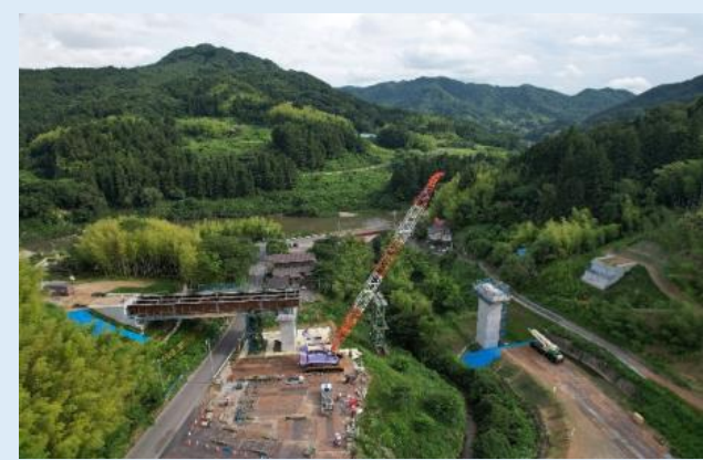
④ 橋梁上部工工事の様子
