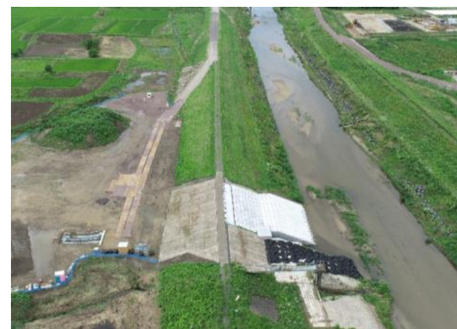
内川樋管工事完了後の様子（字中平西）
