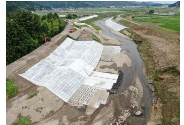
内川山下堰工事の様子（字上林東）
