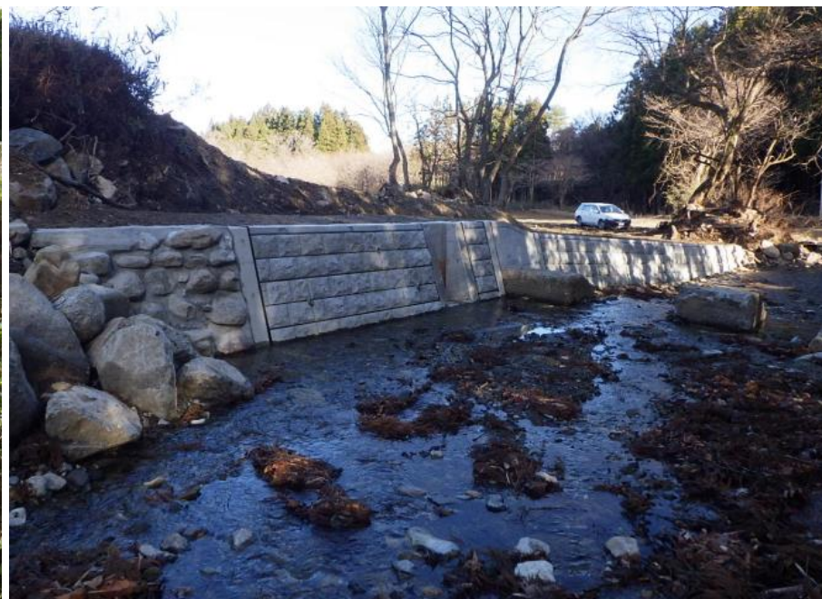
青葉西地区頭首工工事完了後の様子（大内地区）
