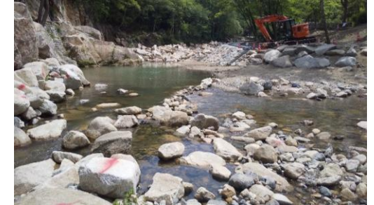
頭首工実施予定箇所 (丸森町字不動)
