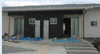
神明住宅(木造)建設工事の様子
