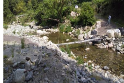
馬淵橋梁工事実施予定箇所(丸森町字馬淵)
