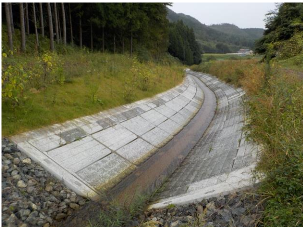
聖川復旧後の様子（大内字高田）
