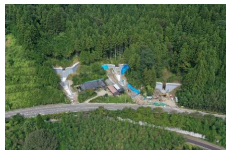
砂防堰堤流路工事の様子(大張川張字片倉)
