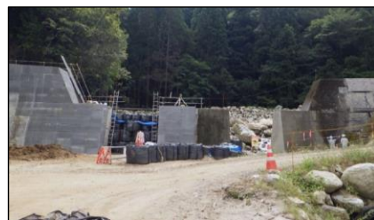
砂防堰堤工事の様子(丸森町字土ヶ森)
