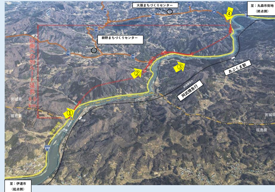
① トンネル掘削中
