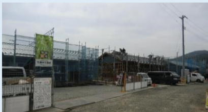
神明北住宅(木造)建設工事の様子
