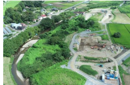
中平橋下流左岸樋門工事の様子(大内字中平)
