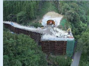
③ トンネル坑口部擁壁施工中
