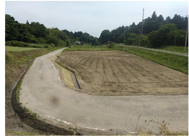
農地復旧後の様子（丸森町字羽出庭）
