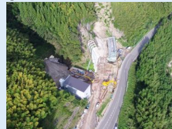
③ トンネル坑口部擁壁施工中
