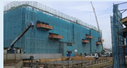
神明住宅(RC造)建設工事の様子
