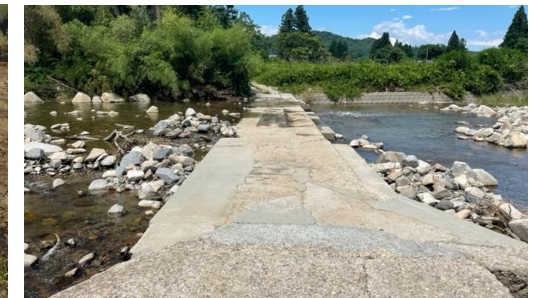
頭首工復旧後の様子(丸森町字石宇)
