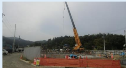
神明北住宅(RC造)躯体工事の様子
