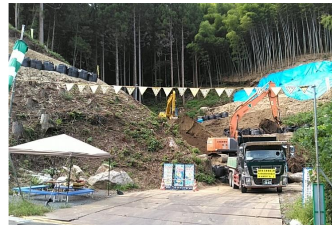
砂防堰堤工事（新築）の様子（字原場）
