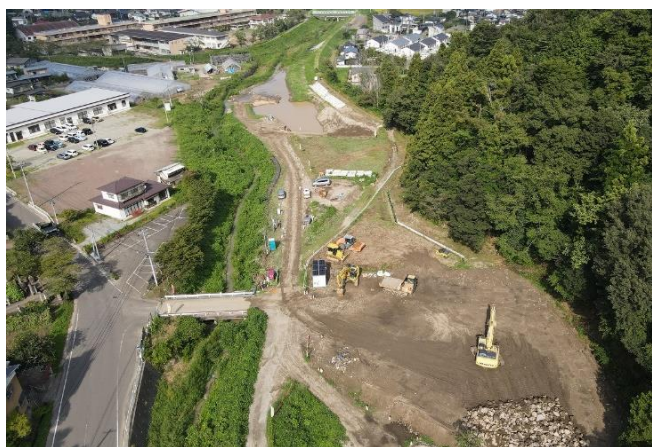
遊砂地工事の様子（字虚空蔵下）
