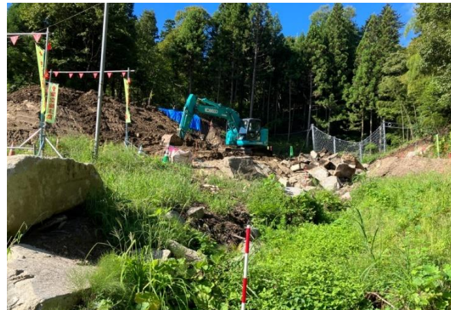
砂防堰堤工事（新築）の様子（筆甫字川下三）
