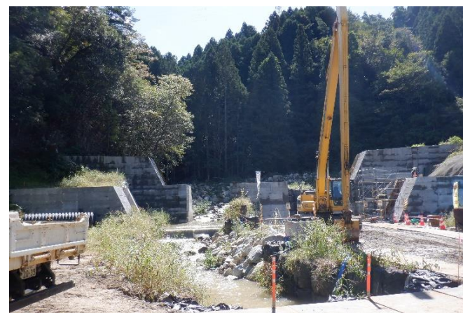
砂防堰堤工事（改築）の様子（字土ヶ森）
