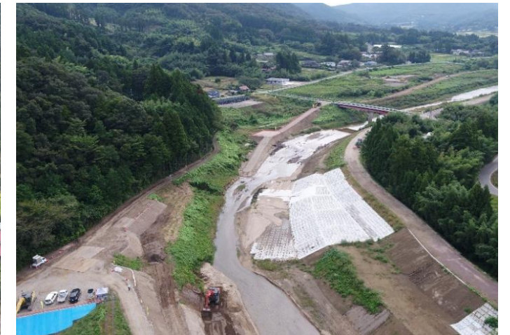
内川山下堰工事の様子（字上林東）
