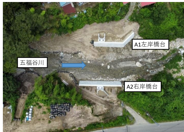
馬淵橋橋梁工事の様子 (6月から10月までの出水期は河川内工事は休止)
