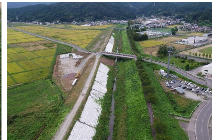
新川築堤工事の様子（字愛宕田）
