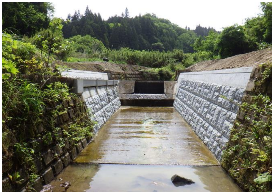
岩ノ入第1頭首工工事（大内地区）
