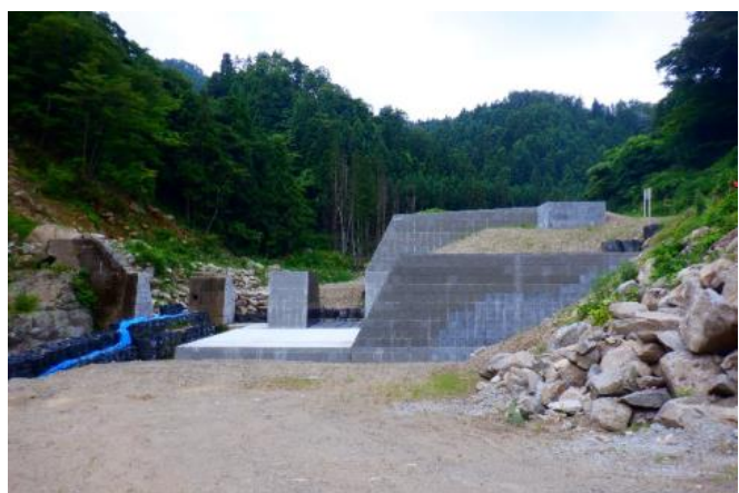
砂防堰堤工事（改築）の様子（字薄平）
