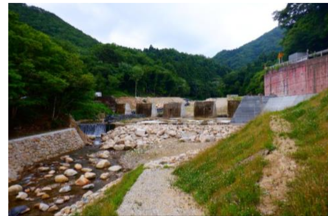
砂防堰堤工事（改築）の様子（字不動）
