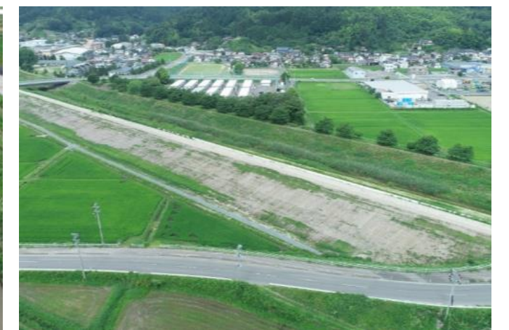
新川築堤工事の様子（字愛宕田）
