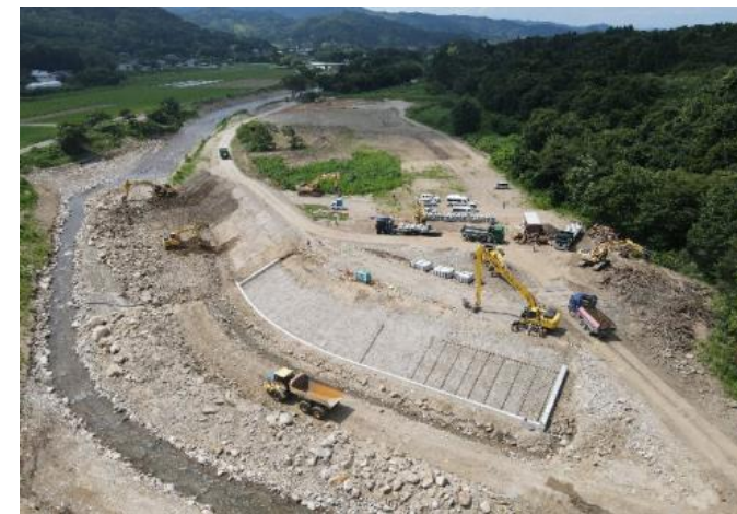
内川護岸工事の様子（字桜淵）
