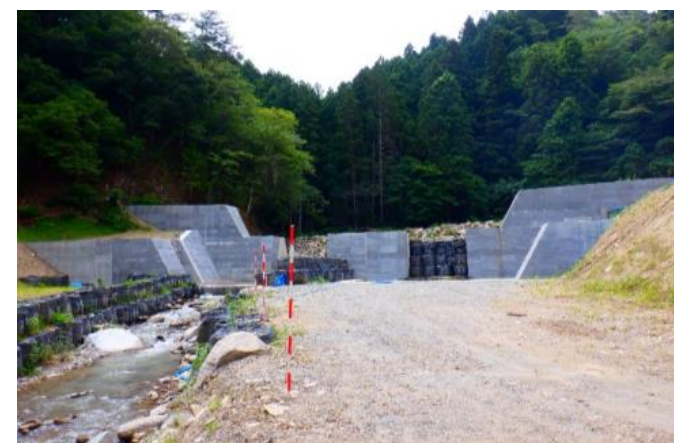
砂防堰堤工事（改築）の様子（字土ヶ森）
