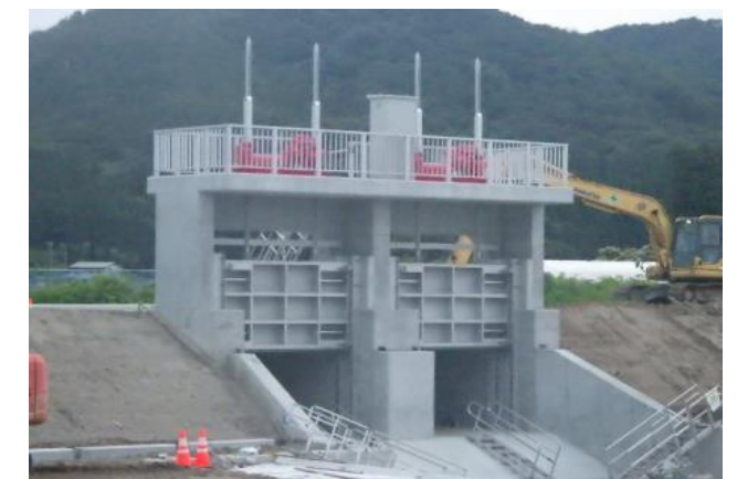
排水樋門ゲート工事 施工中
