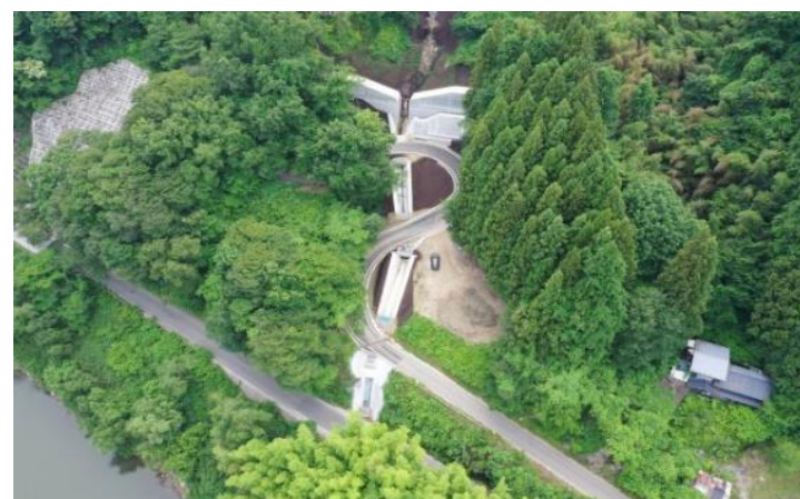
阿武隈川左岸砂防流路工事(左岸8)完成(槌屋沢1)
