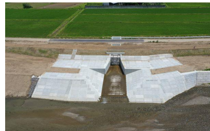
排水樋門工事 完成
