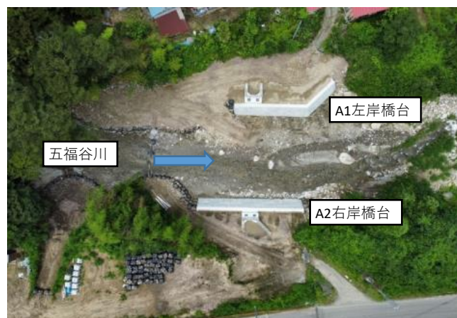
馬淵橋橋梁施工状況
