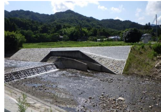
内川護岸工事完了後の様子（字滝原）
