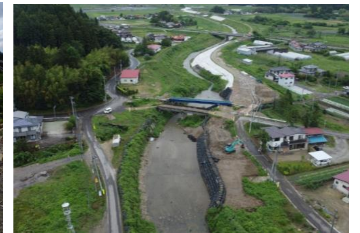
五福谷川河道掘削工事の様子（字塚田）
