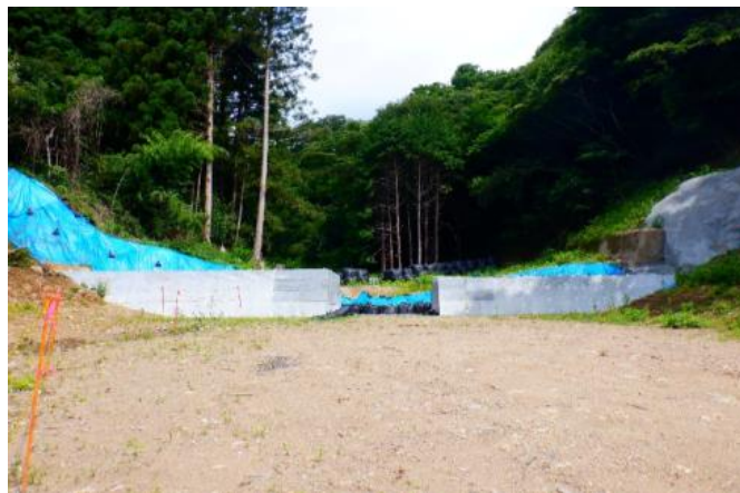
砂防堰堤工事（新築）の様子（字大畑）
