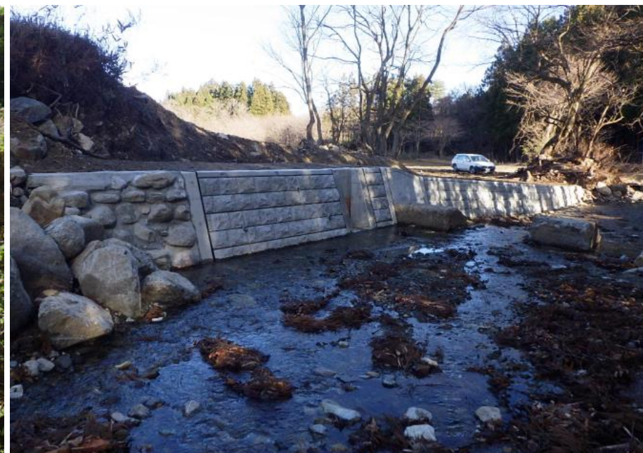
青葉西地区頭首工工事（大内地区）
