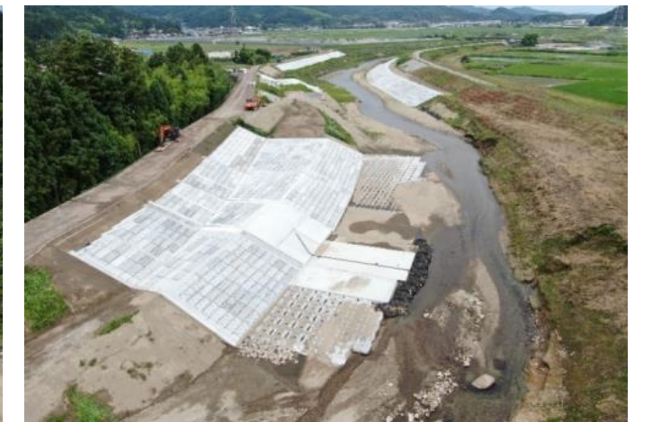
内川山下堰工事の様子（字上林東）
