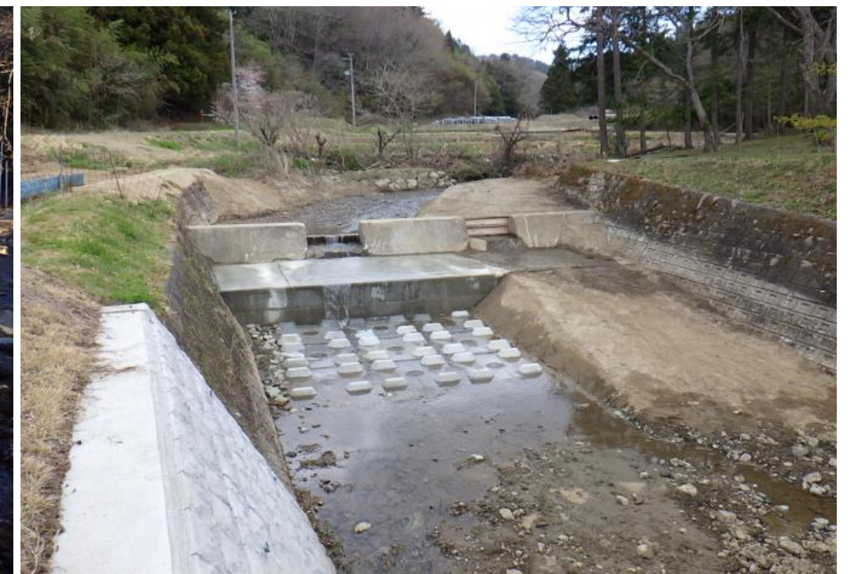
鬼ヶ柵地区頭首工工事（大内地区）
