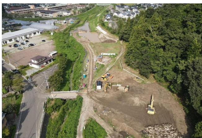
遊砂地工事の様子（字虚空蔵下）
