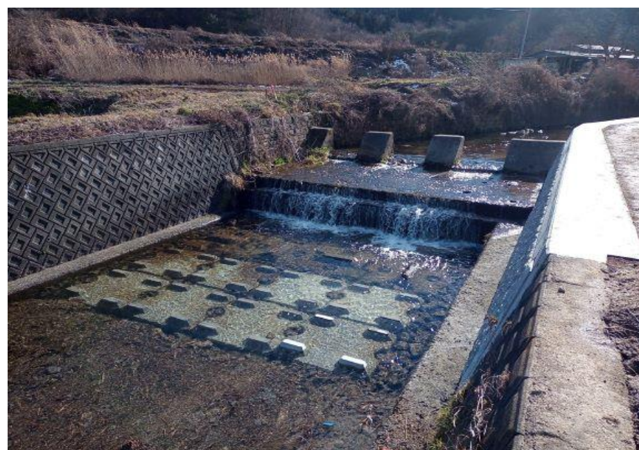
下南山頭首工工事完了後の様子（筆甫地区）
