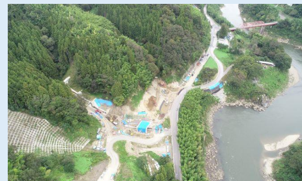
③ 沼地区擁壁工事の様子（羽出庭大橋付近）
