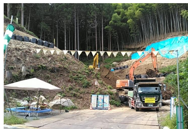
砂防堰堤工事（新築）の様子（字原場）
