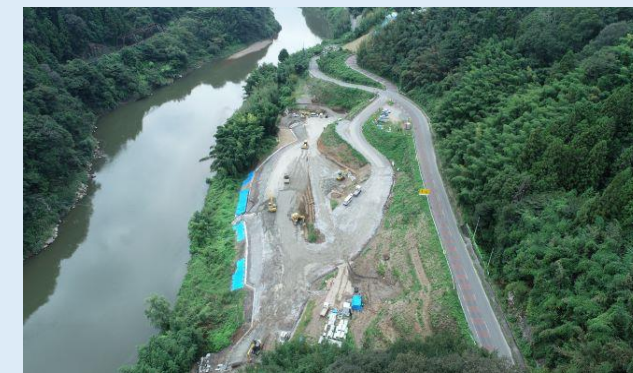
④ 丸森側終点 館地区盛土工事の様子
