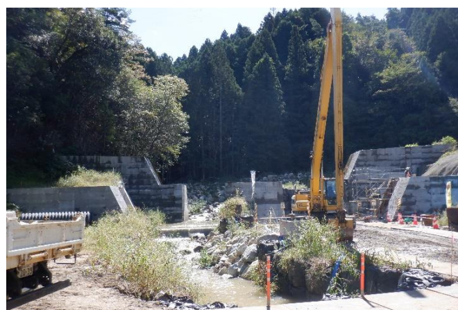
砂防堰堤工事（改築）の様子（字土ヶ森）
