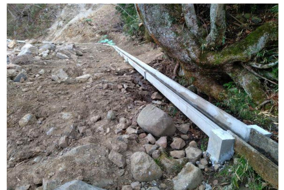
裏区下水路復旧工事の様子（筆甫地区）
