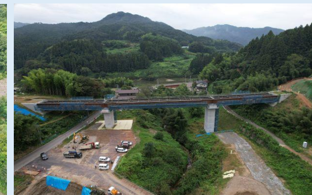
② 第2号橋工事の様子（やしまや付近）
