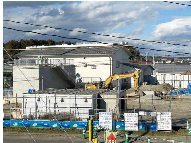
完成が待たれる新ポンプ場（丸森神明地区）
