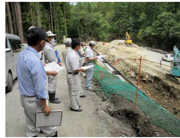
復旧工事の現場を調査する産建教育常任委員会（林道鷲の平線）
