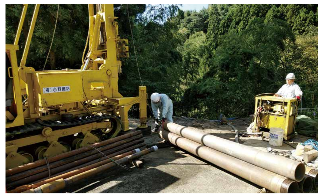
命の水を確保 大規模な井戸掘り工事 (大張地区)
