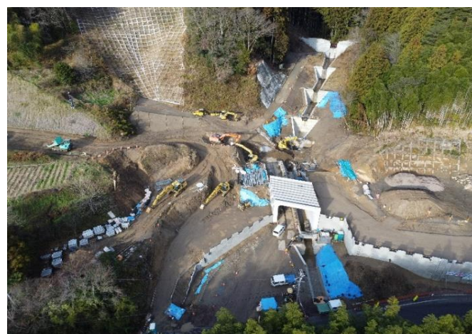
阿武隈川左岸砂防流路工事(その2)の様子(耕野地区)
