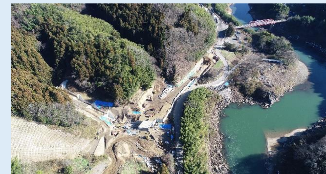
③ 沼地区擁壁工工事の様子（羽出庭大橋付近）
