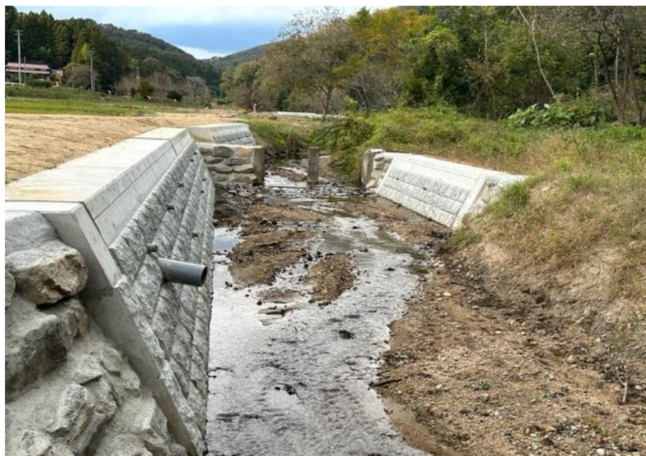
小坂川河川災害復旧工事完了後の様子（館矢間地区）
