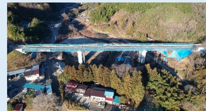
① 第1号橋工事の様子（八島工業(株)付近）
