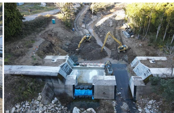
砂防堰堤工事（改築）の様子（字土ヶ森）
