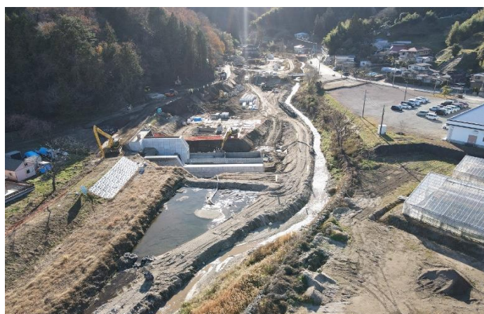
遊砂地工事の様子（字虚空蔵下）
