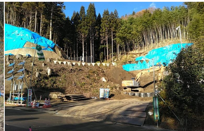
砂防堰堤工事（新築）の様子（字原場）
