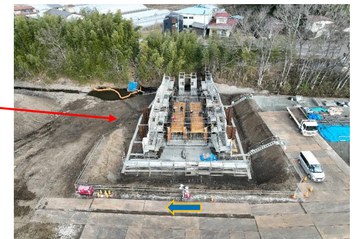
排水樋門工事(その2)の様子(拡大)
