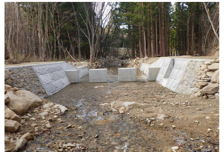
大平頭首工工事完了後の様子（大内地区）
