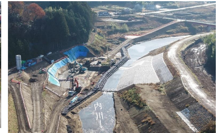
内川山下堰工事の様子（字上林東）
