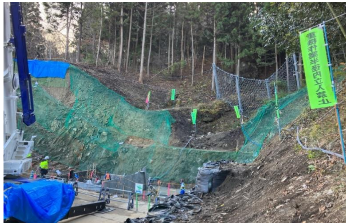
砂防堰堤工事（新築）の様子（筆甫字川下三）
