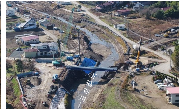
旧五福谷橋 旧橋撤去の様子（字塚田）
