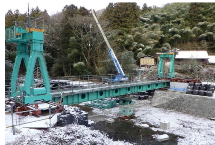
馬淵橋梁上部工架設工事の様子(丸森地区)
