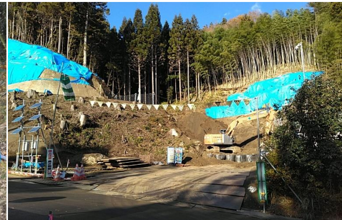
砂防堰堤工事（新築）の様子（字原場）
