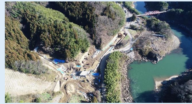
③ 沼地区擁壁工工事の様子（羽出庭大橋付近）
