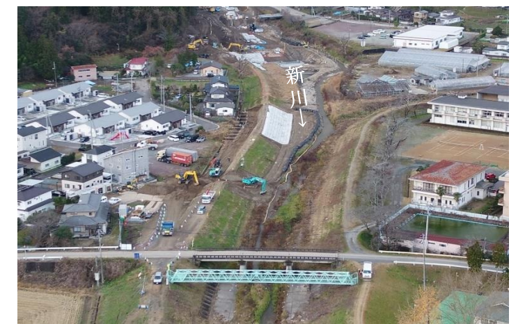
新川樋管工事の様子（字飯泉）
