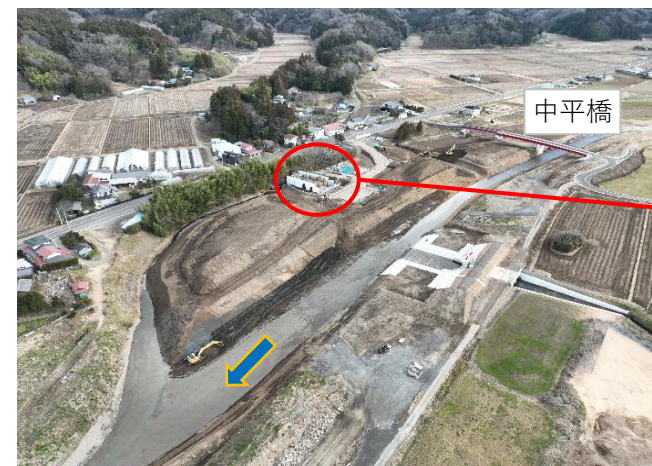
排水樋門工事(その2)の様子(中平橋付近)
