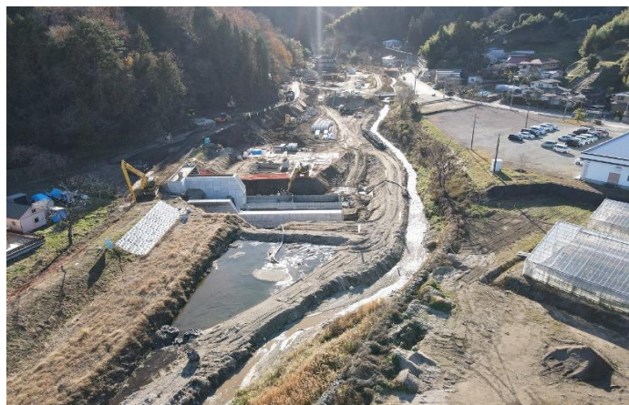
遊砂地工事の様子（字虚空蔵下）
