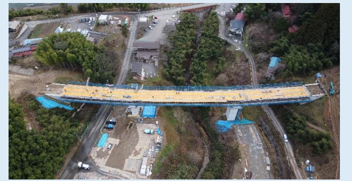
② 第2号橋工事の様子（やしまや付近）
