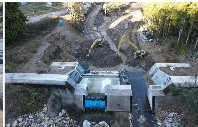
砂防堰堤工事（改築）の様子（字土ヶ森）
