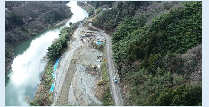
④丸森側終点 館地区盛土工事の様子
