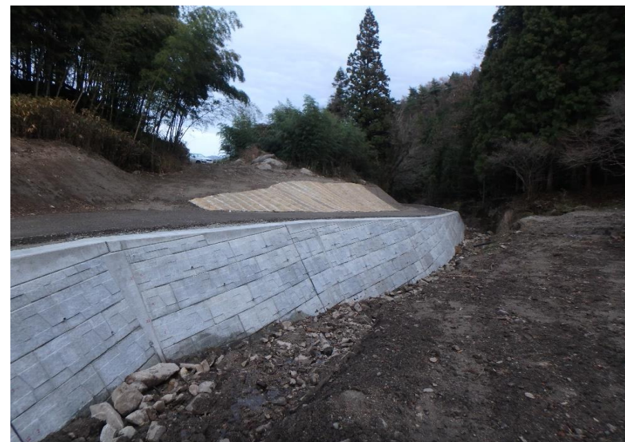
柳田地区農道工事完了後の様子（丸森地区）
