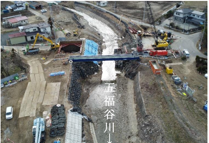
旧五福谷橋 旧橋撤去の様子（字塚田）
