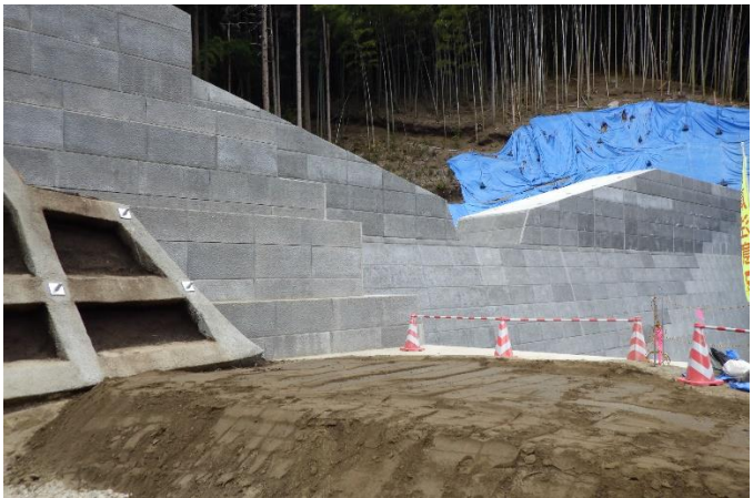
砂防堰堤工事（新築）の様子（字原場）
