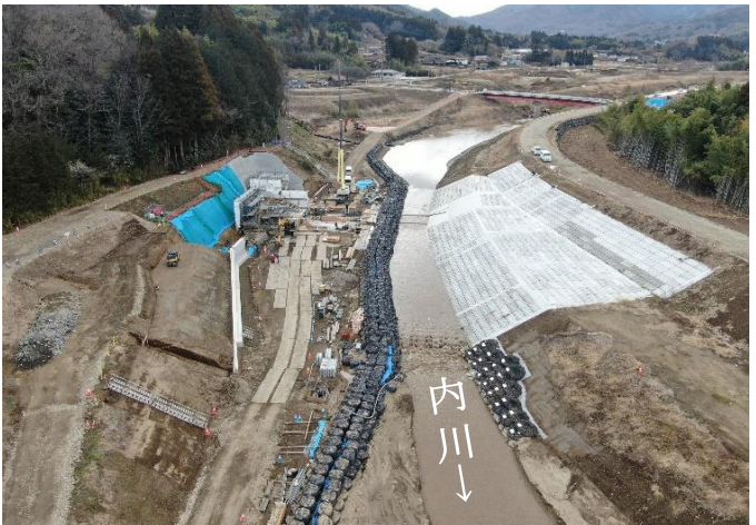
内川山下堰工事の様子（字上林東）
