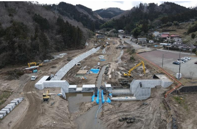
遊砂地工事の様子（字虚空蔵下）
