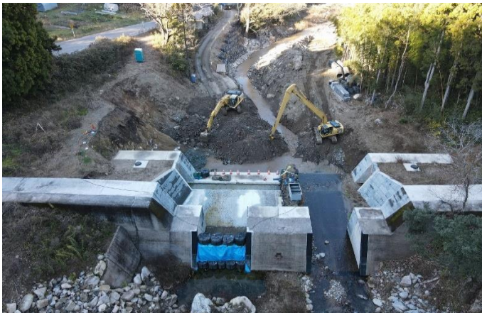
砂防堰堤工事（改築）の様子（字土ヶ森）
