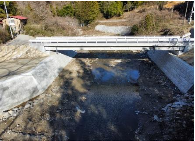
馬淵橋梁完成の様子（丸森地区）
