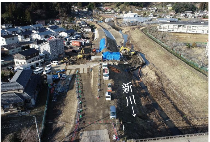
新川樋管工事の様子（字飯泉）
