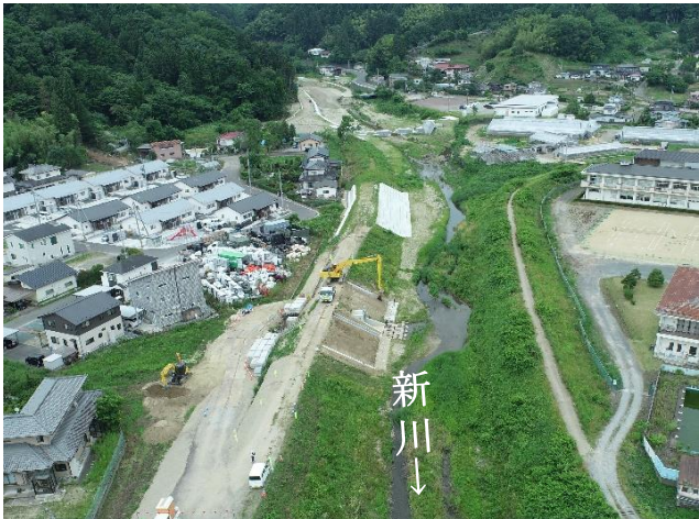
新川樋管工事の様子（字飯泉）
