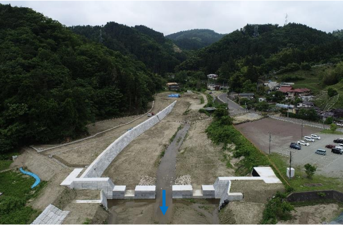
遊砂地工事の様子（宇虚空蔵下）
