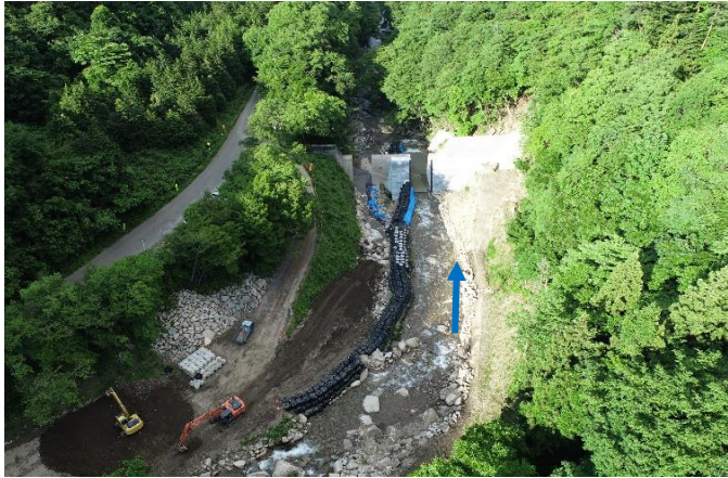
砂防堰堤工事（改築）の様子（宇東山）
