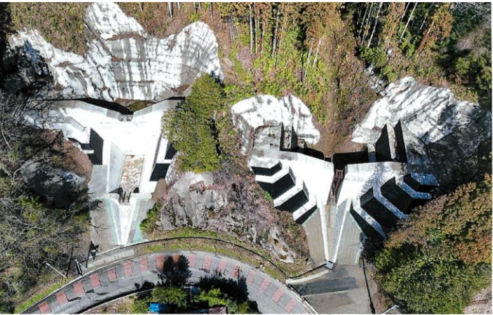
阿武隈川左岸砂防流路工事（その1）完成の様子 （大張地区）
