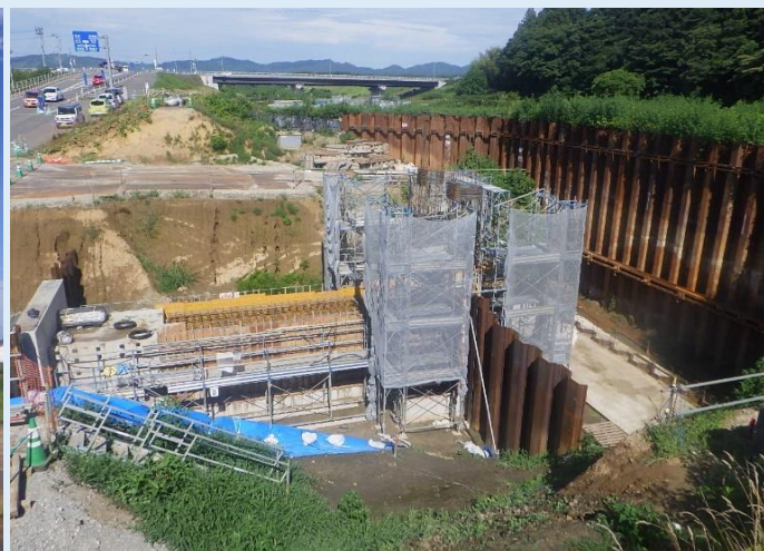
新設雨水ポンプ場放流渠の様子
