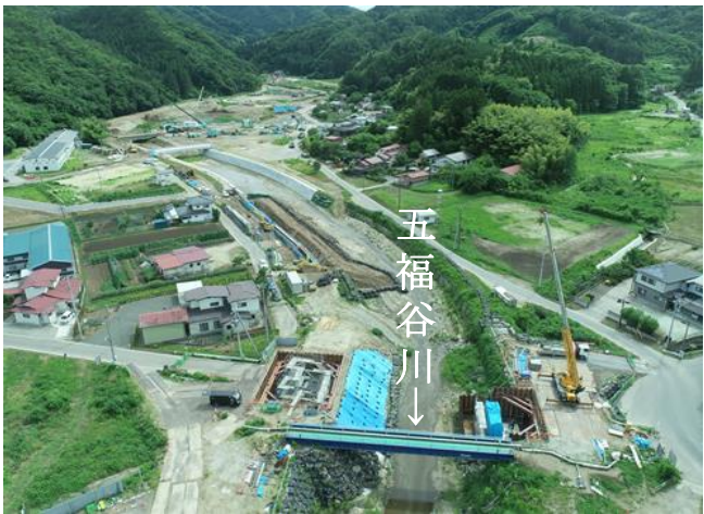
旧五福谷橋 旧橋撤去の様子（字塚田）
