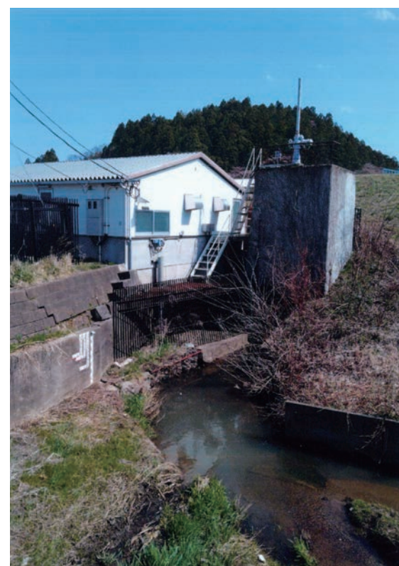
丸森雨水ポンプ場
