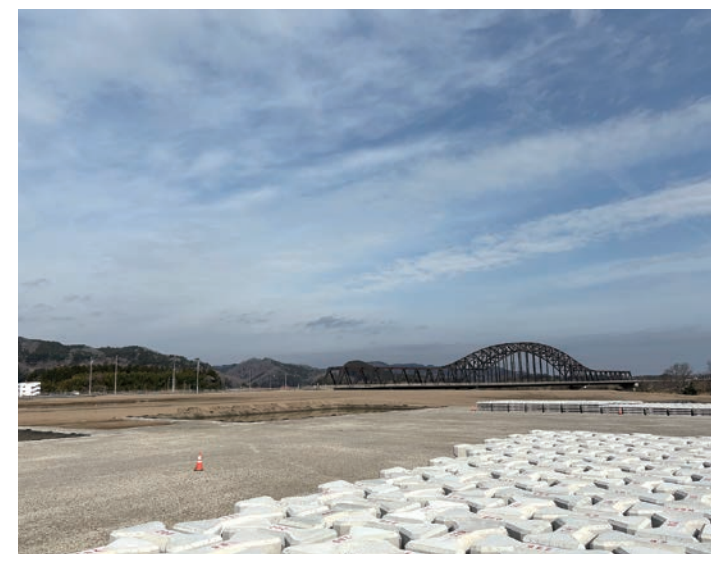
整備が進む河川防災ステーション
