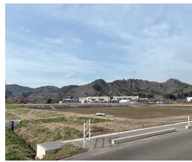
歩道も整備され、企業誘致に向け準備万端 (金山工場団地)
