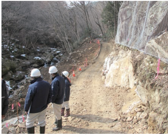
復旧工事を阻む強固な岩盤
