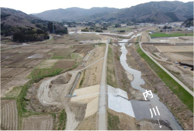
内川築堤工事の様子（字中平西）
