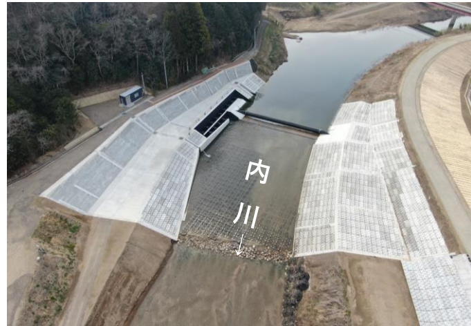
内川山下堰工事施工完了（字上林東）
