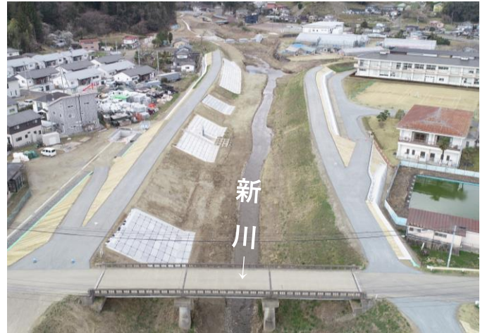
新川樋管工事施工完了（字飯泉）
