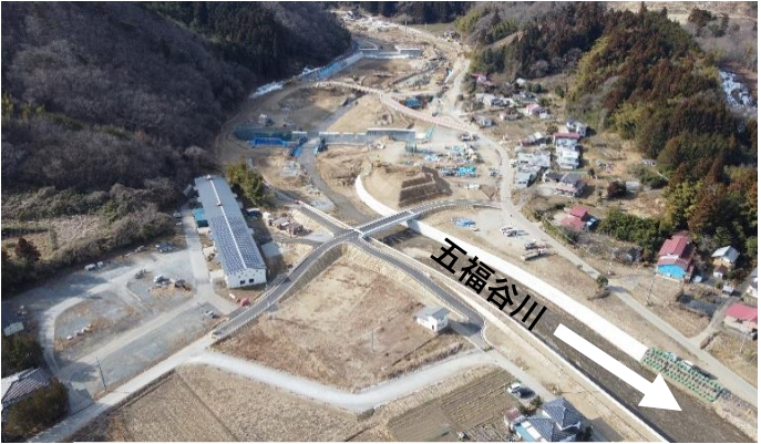
五福谷川遊砂地工事（新築）の様子
