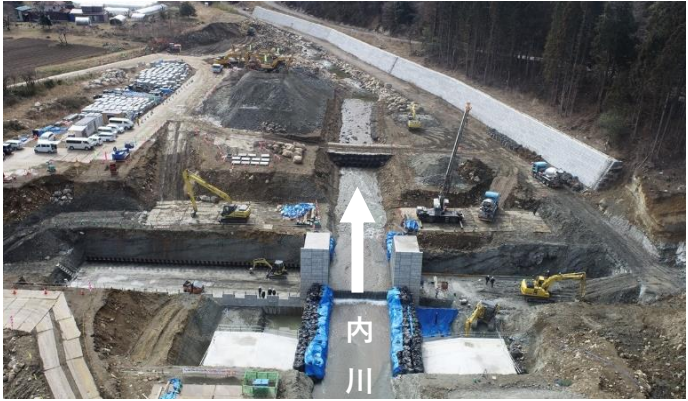
内川遊砂地工事（新築）の様子
