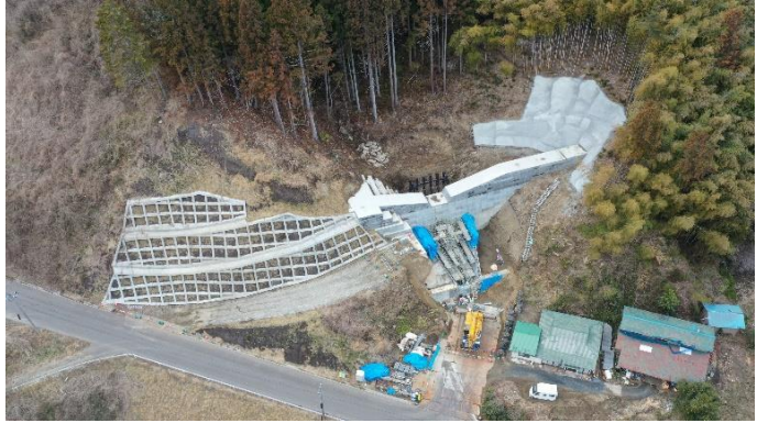
川下三砂防堰堤工事（新築）の様子 （字原場）
