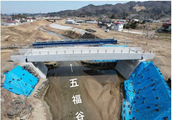
五福谷橋工事の様子（字塚田）
