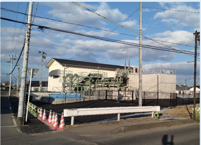
新設雨水ポンプ場建屋の様子
