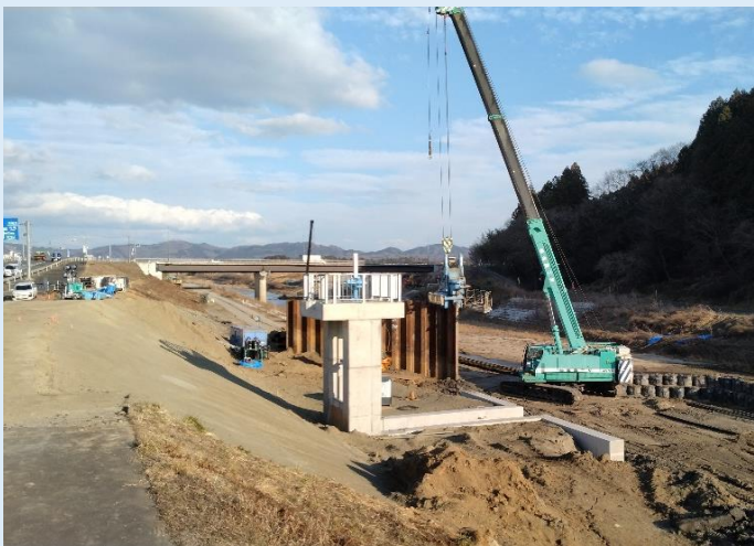
新設雨水ポンプ場放流渠の様子
