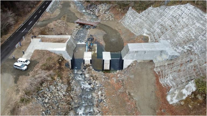
鷺の平砂防堰堤ほか工事（新築）の様子 （字薄平）
