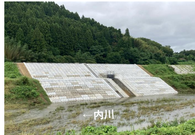
内川樋管工事施工完了（字沼ノ下）
