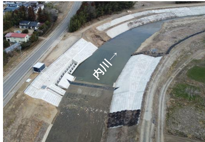
内川和田堰工事施工完了（字稲葉）
