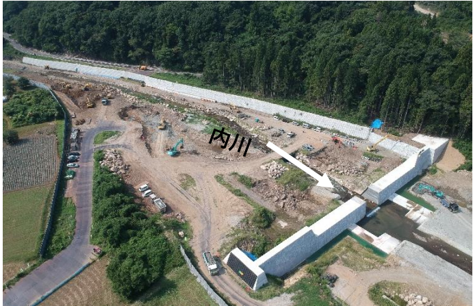
内川遊砂地工事（新築）の様子
