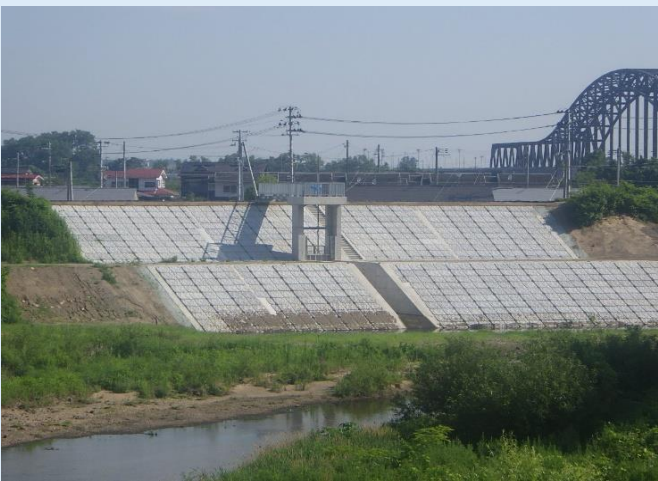
新設雨水ポンプ場放流渠の様子
