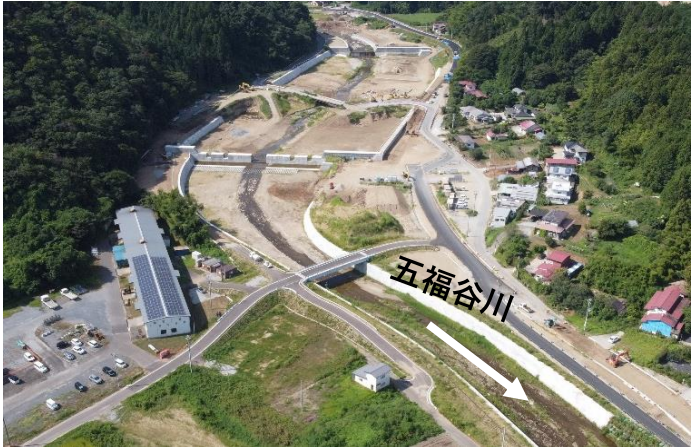
五福谷川遊砂地工事（新築）の様子
