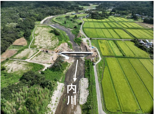
内川築堤工事の様子（字下矢田）
