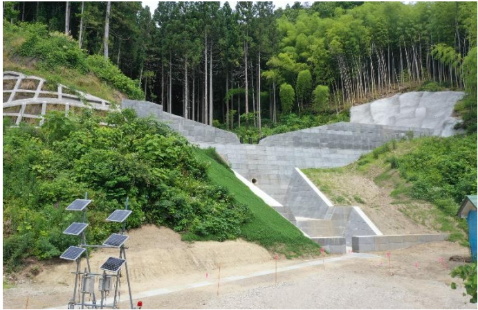
川下三砂防堰堤工事（新築）の様子 （字原場）
