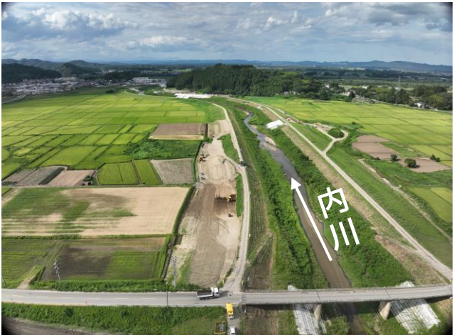
内川築堤工事の様子（字中平西）
