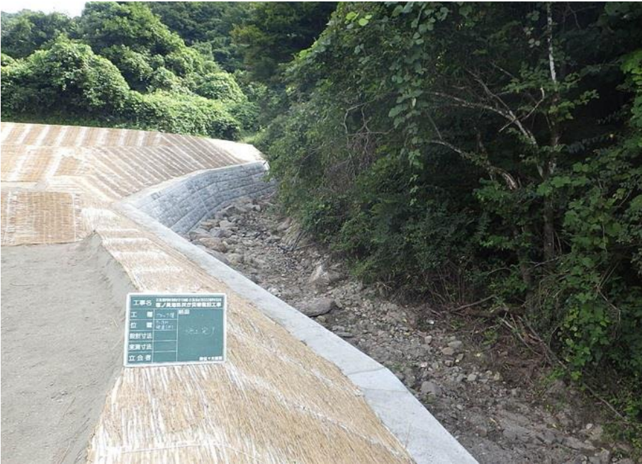
耕野地区坂下川工事完了後の様子（耕野地区）
