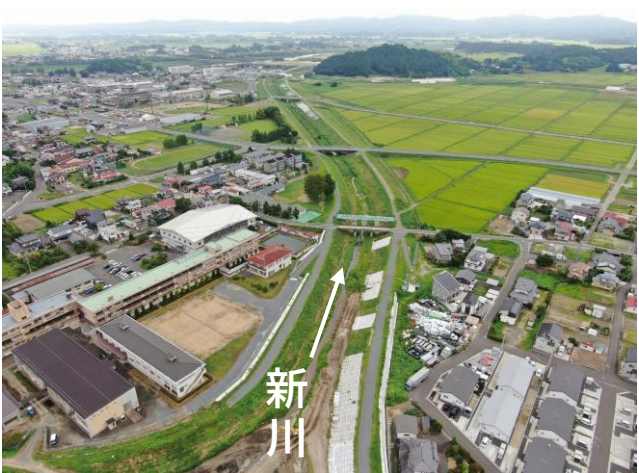
新川築堤工事の様子（字飯泉）
