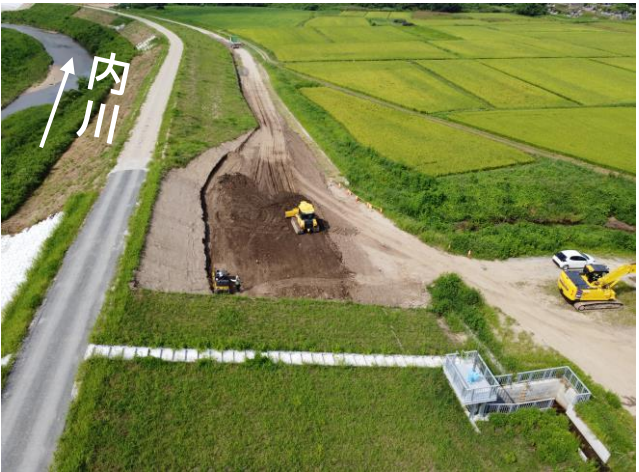
内川築堤工事の様子（字中平北）
