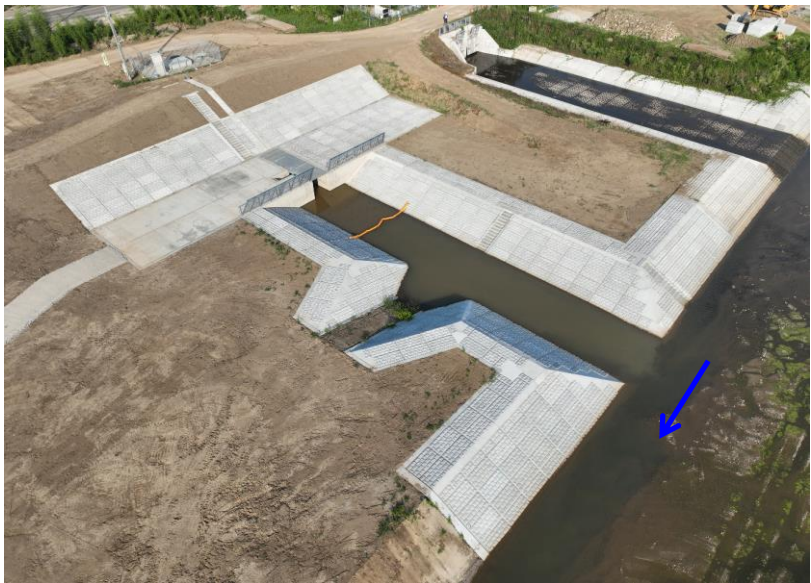
沢田揚水機場改築工事 完成
