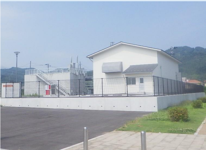
新設雨水ポンプ場建屋の様子
