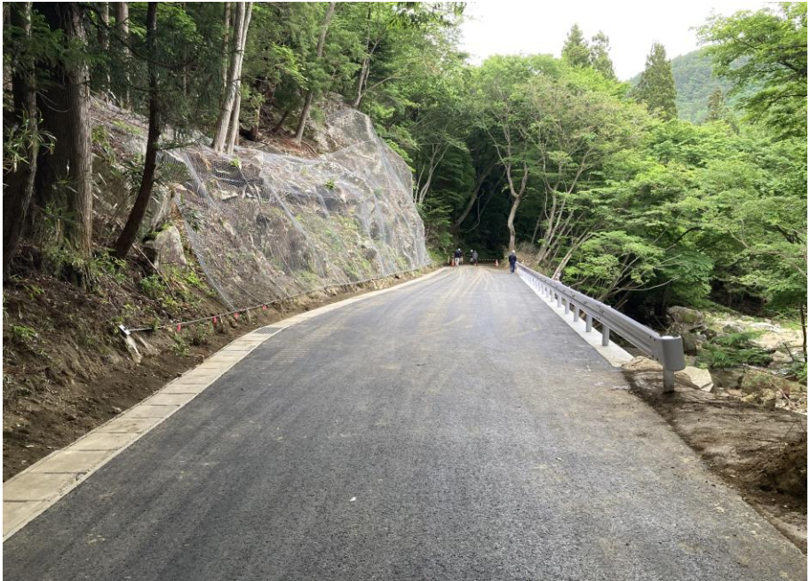
林道鷲の平線工事完了後の様子（筆甫地区）
