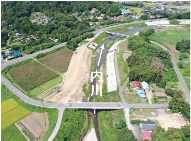
内川築堤工事の様子（字稲葉）
