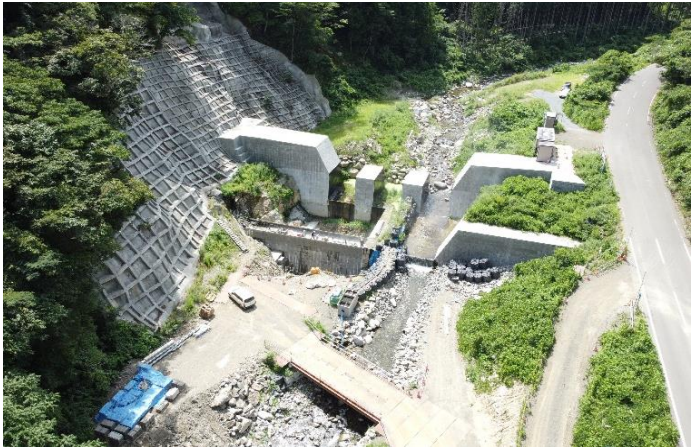
鷺の平砂防堰堤ほか工事（新築）の様子 （字薄平）
