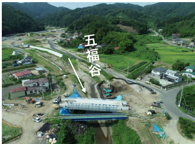
五福谷川樋管工事の様子（字塚田）
