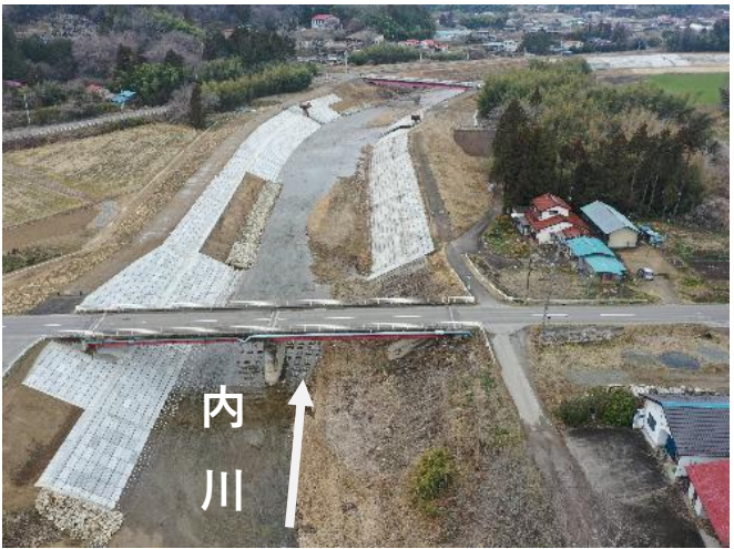
内川築堤工事の様子（字稲葉）
