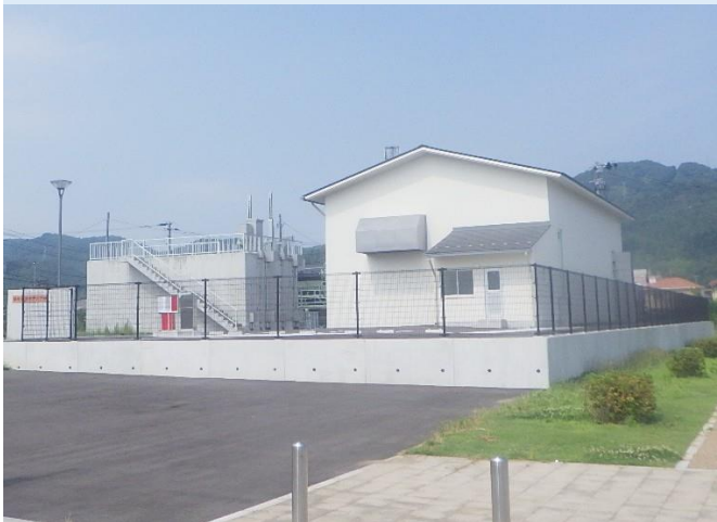
新設雨水ポンプ場建屋の様子
