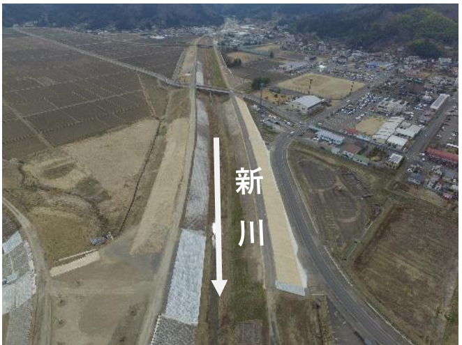
新川築堤工事の様子（字飯泉）
