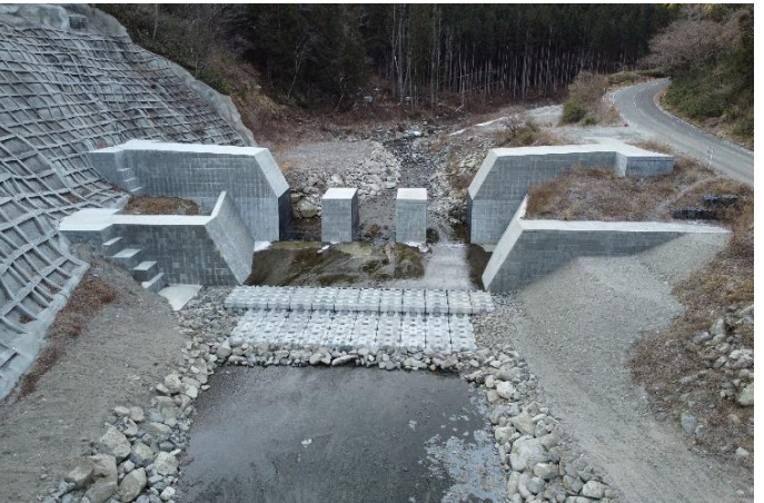
薄平砂防堰堤工事（改築）の様子
