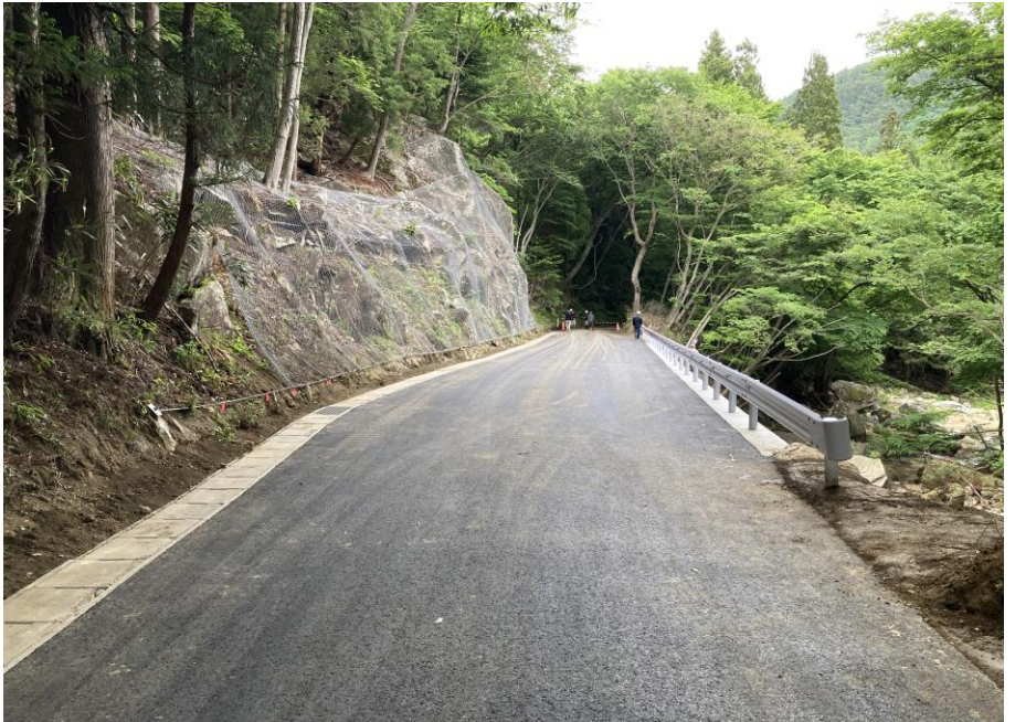
林道鷺の平線工事完了後の様子（筆甫地区）
