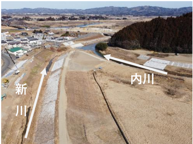
内川築堤工事の様子（字愛宕田）
