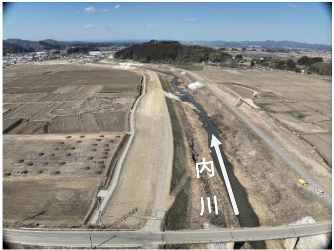
内川築堤工事の様子（字中平西）
