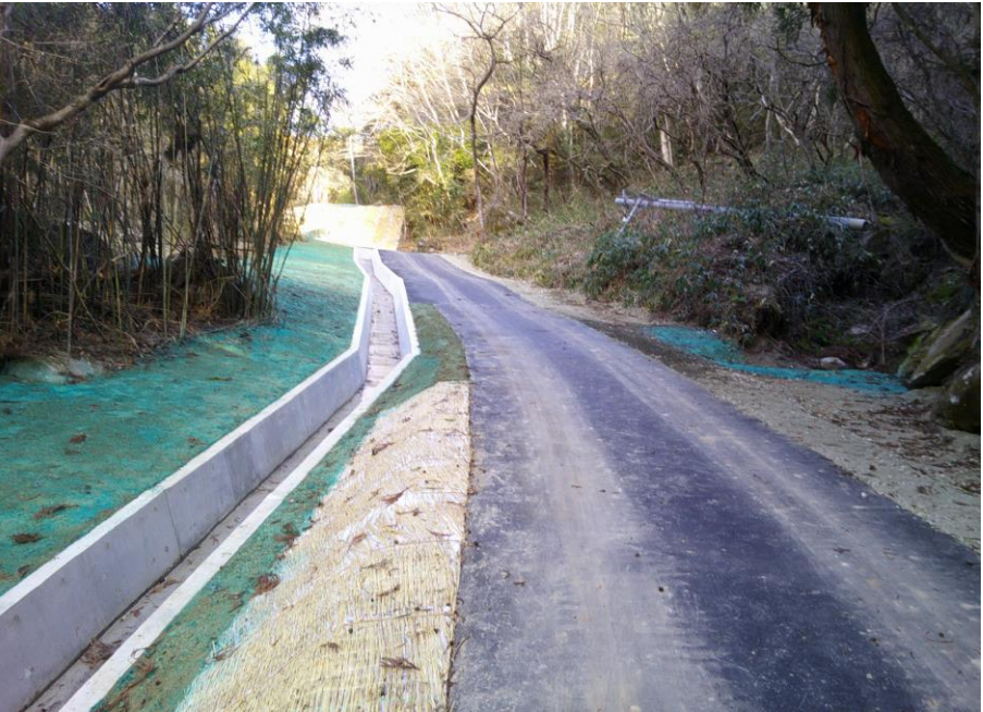
町道西風沢線工事完了後の様子（大張地区）
