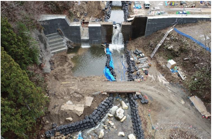
鷺の平砂防堰堤工事（新築）の様子
