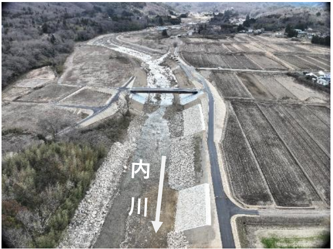
内川築堤工事の様子（字下矢田）
