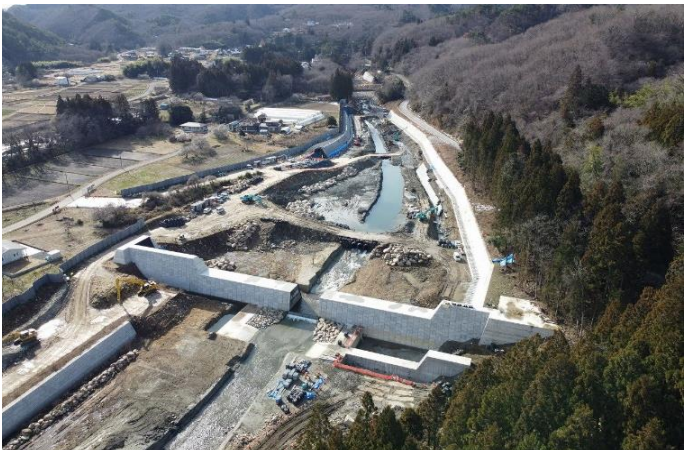
内川遊砂地工事（新築）の様子
