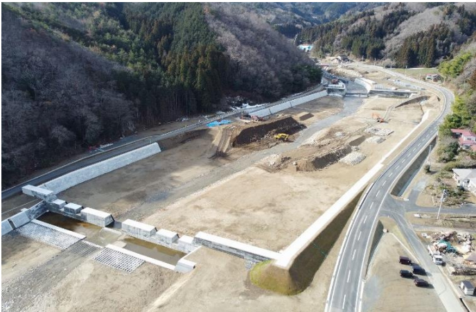
五福谷川遊砂地工事（新築）の様子
