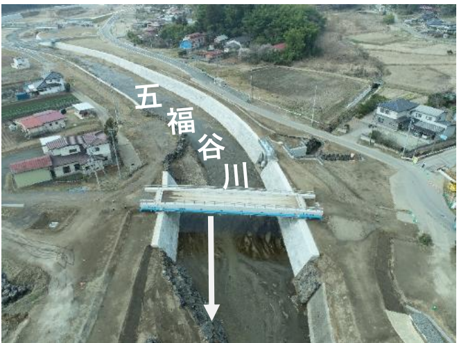
五福谷川樋管工事の様子（字塚田）
