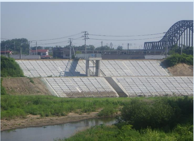
新設雨水ポンプ場放流渠の様子
