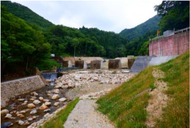
砂防堰堤工事（改築）の様子（字不動）
