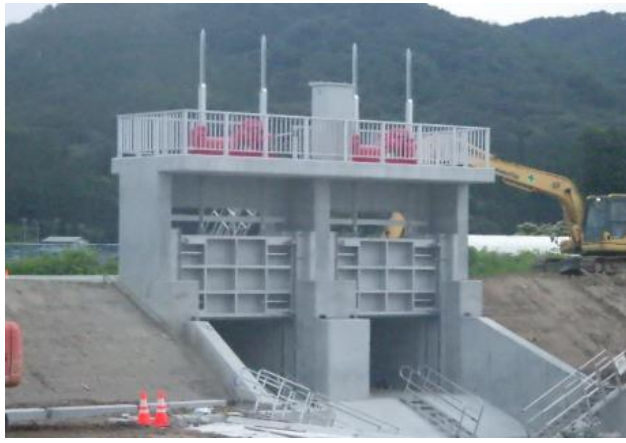
排水樋門ゲート工事の様子
