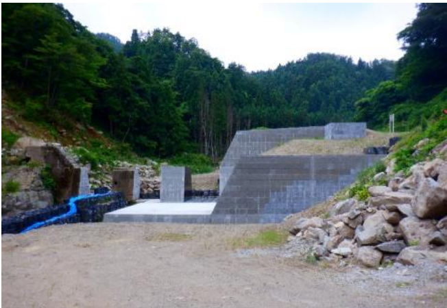
砂防堰堤工事（改築）の様子（字薄平）
