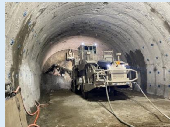
③ 3号トンネル掘削工事の様子
