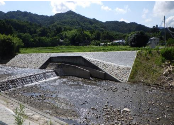
内川護岸工事完了後の様子（字滝原）
