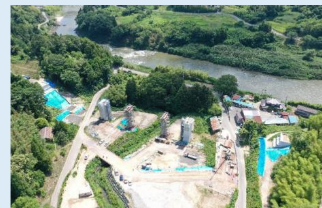
② 第1号橋工事の様子
