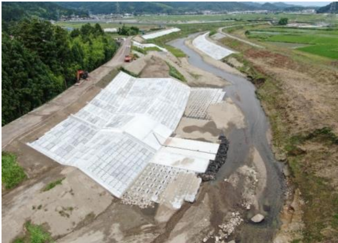
内川山下堰工事の様子（字上林東）
