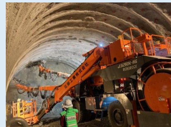
① 1号トンネル掘削工事の様子
