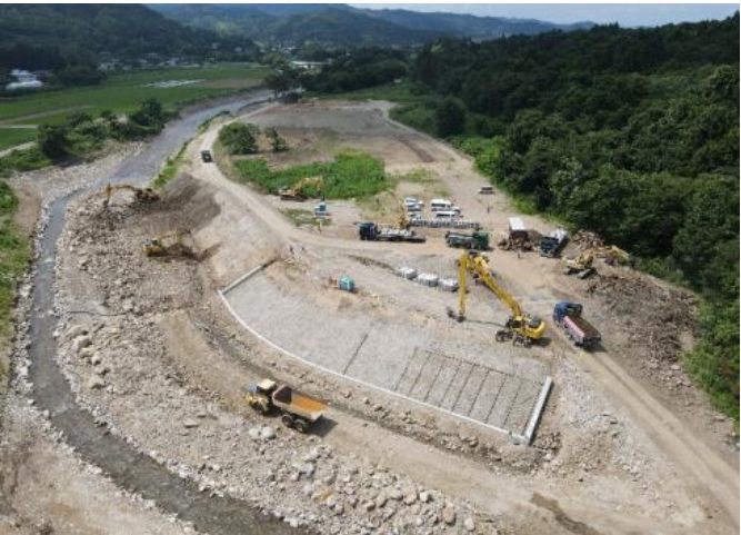
内川護岸工事の様子（字桜淵）
