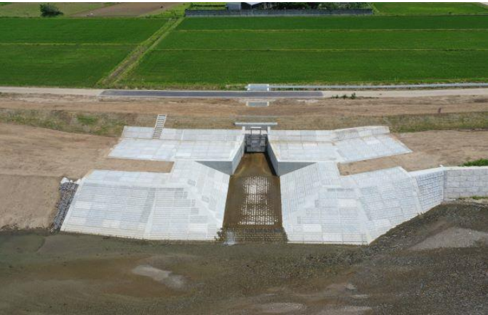
排水樋門工事完了後の様子
