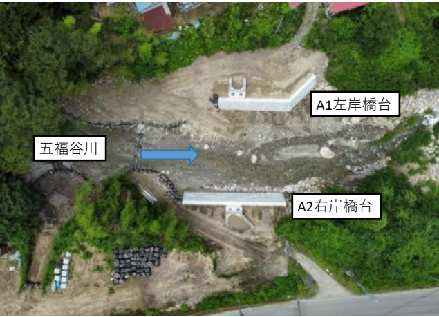
馬淵橋橋梁工事の様子
