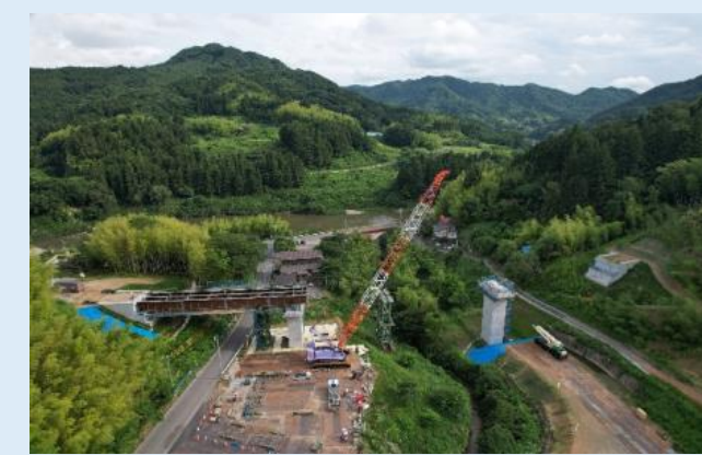
④ 橋梁上部工工事の様子
