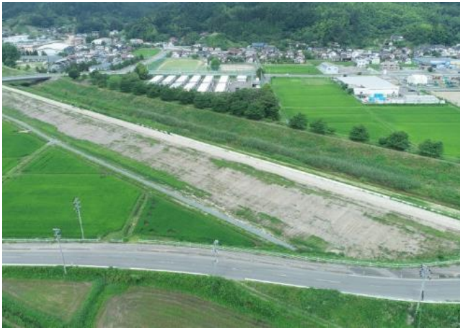
新川築堤工事の様子（字愛宕田）
