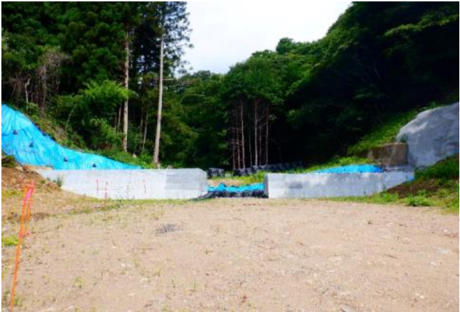
砂防堰堤工事（新築）の様子（字大畑）
