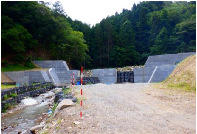
砂防堰堤工事（改築）の様子（字土ヶ森）
