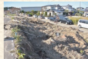
洪水害: きじおがわ 雉子尾川 (金山地区)
